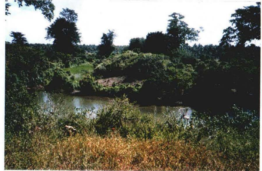
既存ダム欠損部（河道部）
