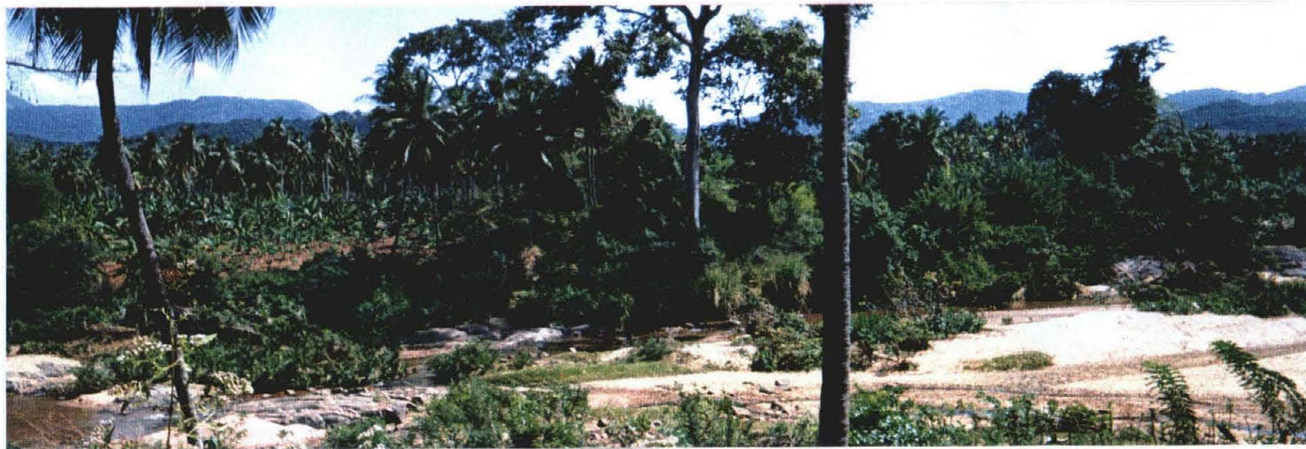
ワンドゥラペーヌエラダム軸（河道部）
