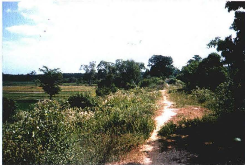
既存ダム（左が池敷予定地）
