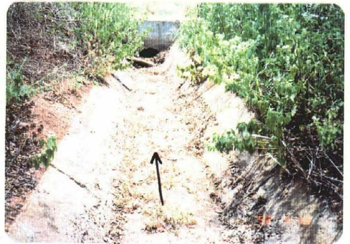
地区内かんがい水路
