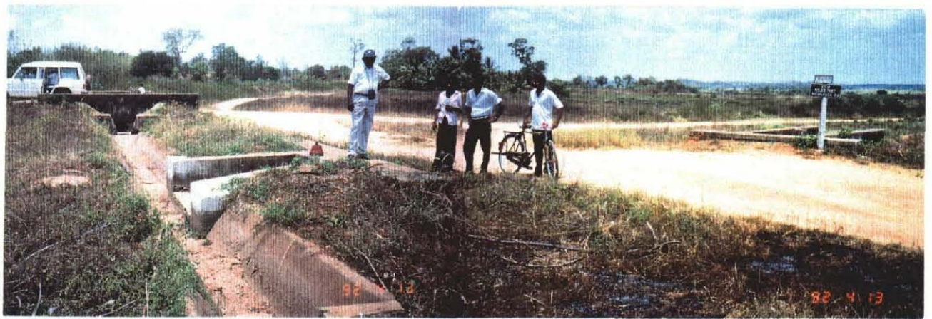
地区内かんがい水路 (D-Channel)
