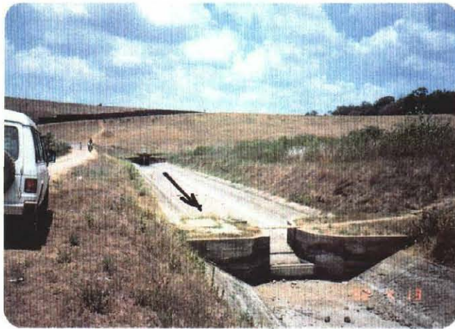
R.B. Main Canal 及び堤体
