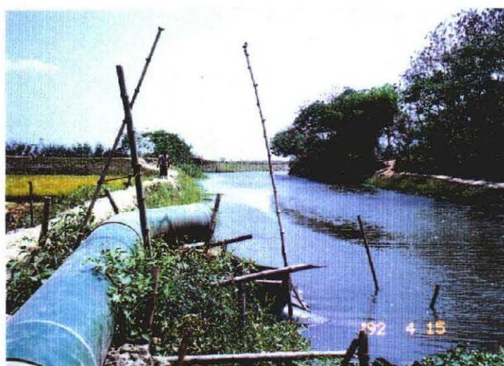
Shahrasti Upazila のNoringbill Scheme 吐出口及び水の供給された運河
