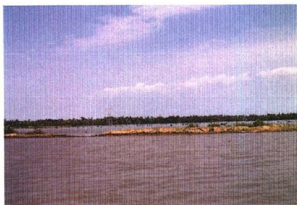
ポルダーNo.37湛水状況
