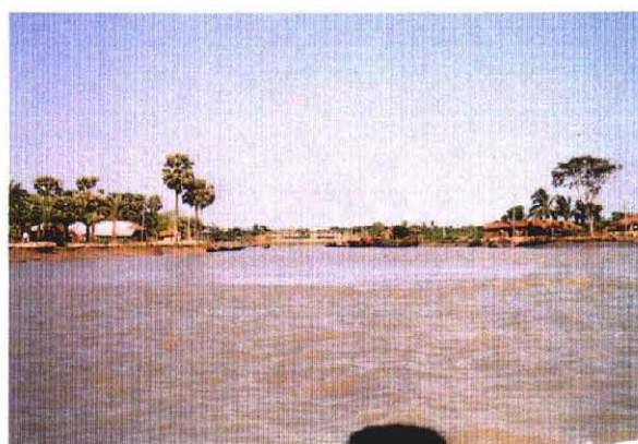
Bishkali水路南側出入口部 (Gashiakhari川より望む)
