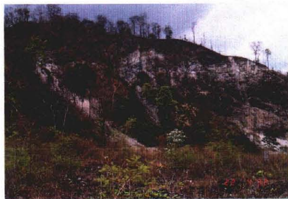
幹線水路建設状況 (予算不足のため現在は建設が中止されている)
