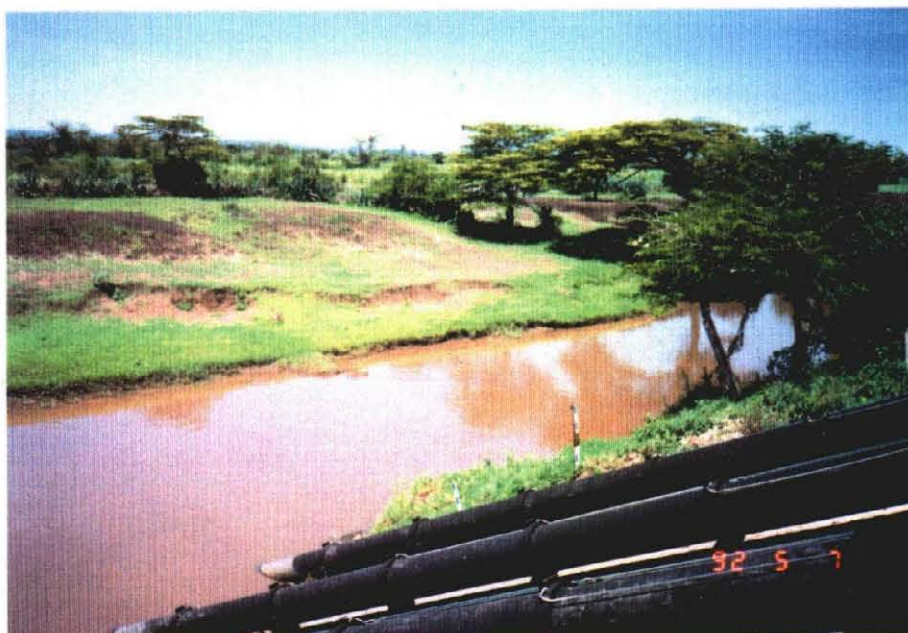
ニヤンド河 (既存灌漑用ポンプ場地点)
