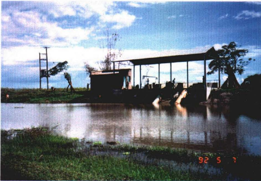
既存排水用ポンプ場 及び幹線排水路
