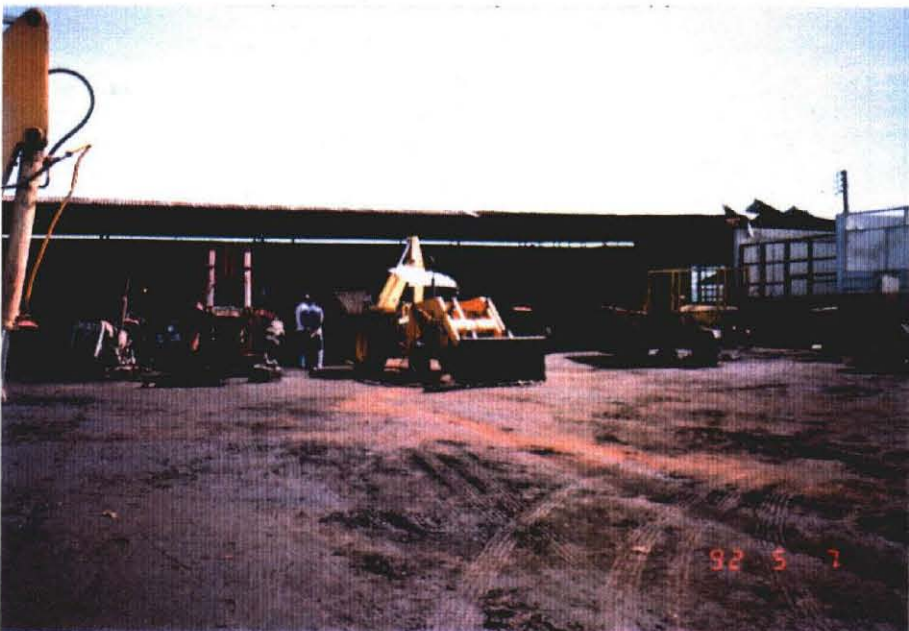
既存機械修理場
