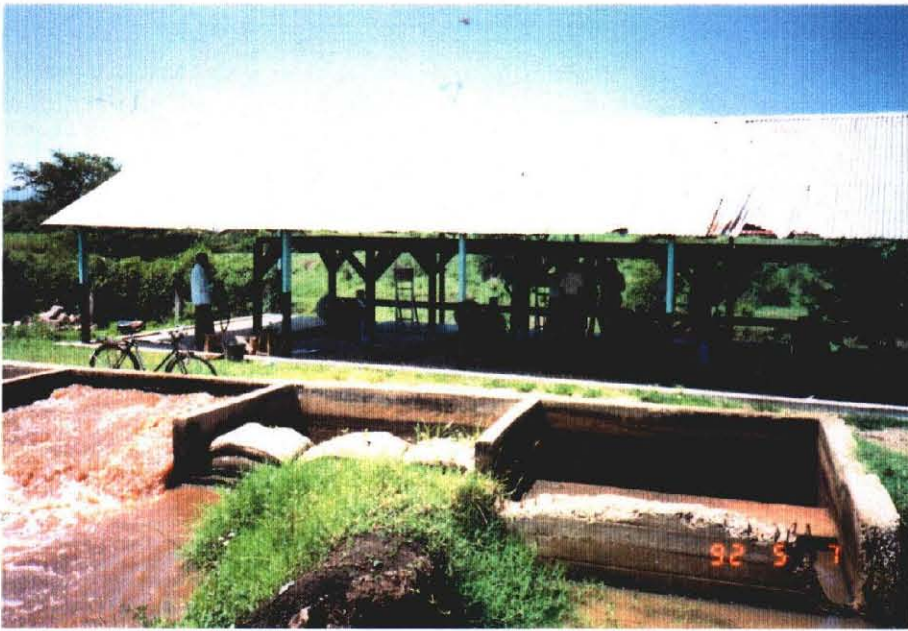
既存灌漑用ポンプ場
