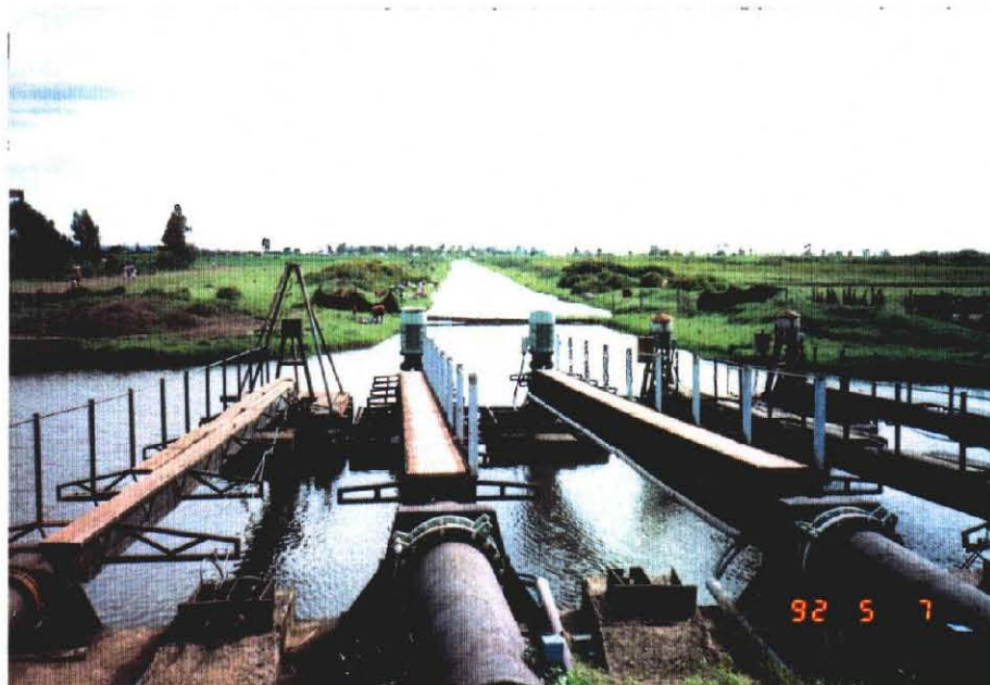
上記ポンプ場より ビクトリア湖からの 接続水路を望む
