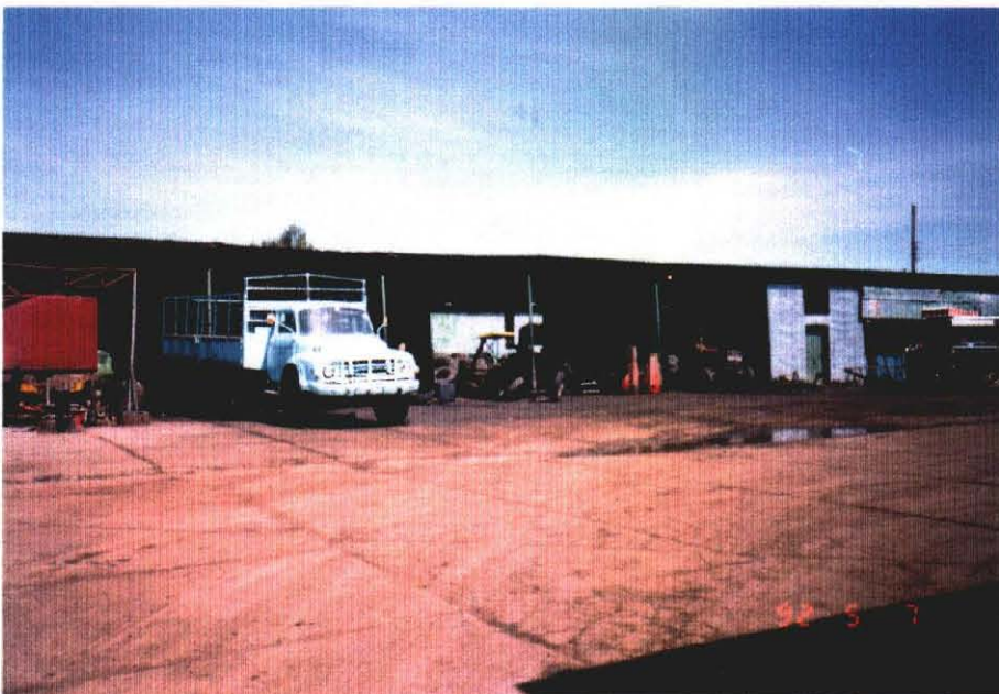
既存機械修理場
