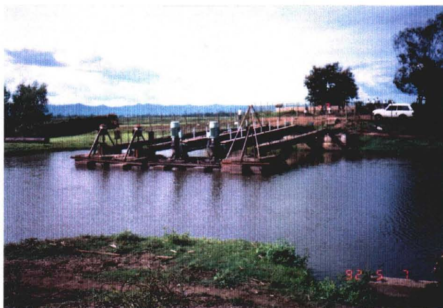
既存灌漑用ポンプ場
