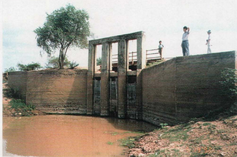
ボルダー堤 排水樋門
