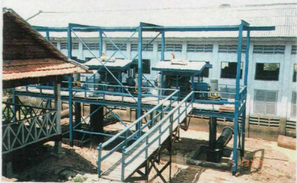
NGOによって建設されたポンプ場
