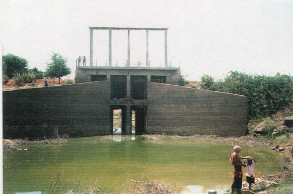
トンレ・サップ川への排水樋門
