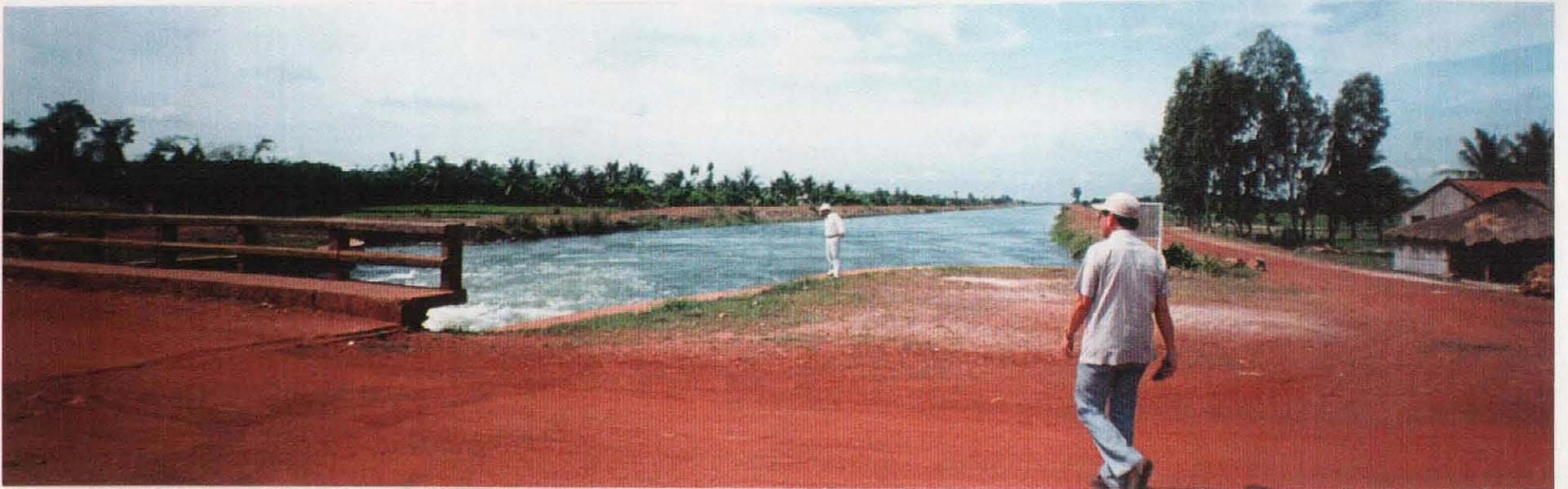
写-8 Dau Tieng Dam 取水の東幹線水路：  $L=45 \text{ km}$ ,  $q=30 \text{ m}^3/\text{sec}$ . 素堀りで、途
