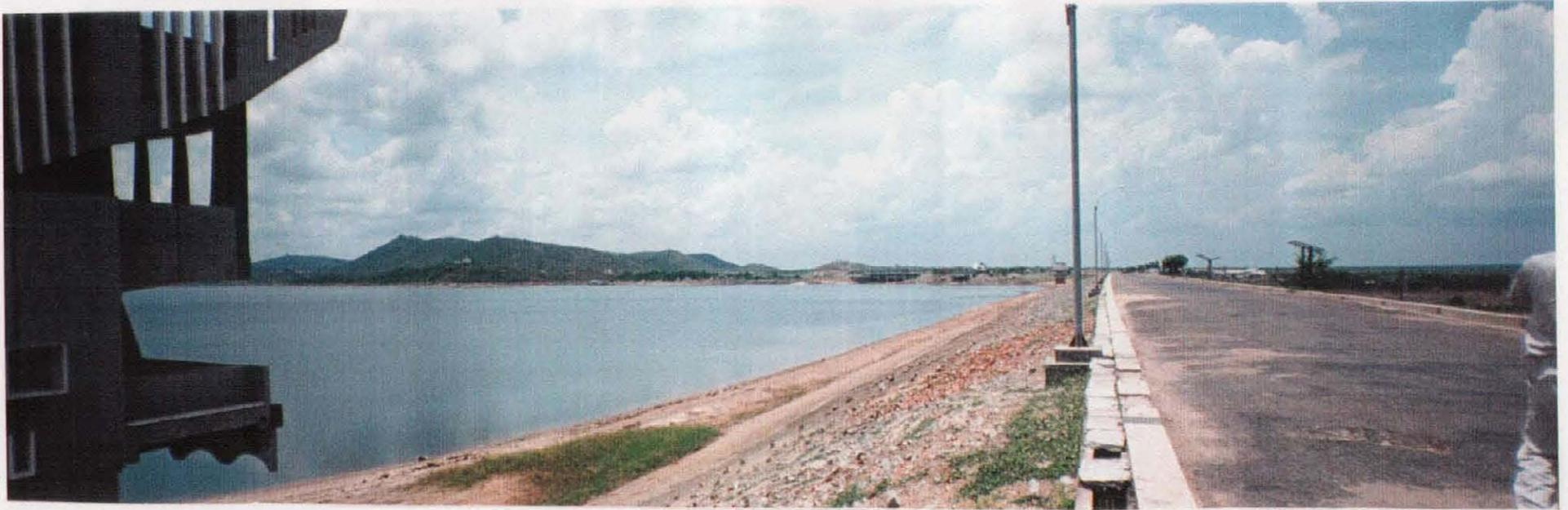
写-7 Dau Tieng Dam 全景： 右側が道路兼用堤頂、左側が貯水池、1986年世銀等の融資とベトナムの国産技術で完成した。フィルダム、 $L=1.1 \text{ km}$ ,  $H=30 \text{ m}$ ,  $V=1,580 \text{ M m}^3$ 。
