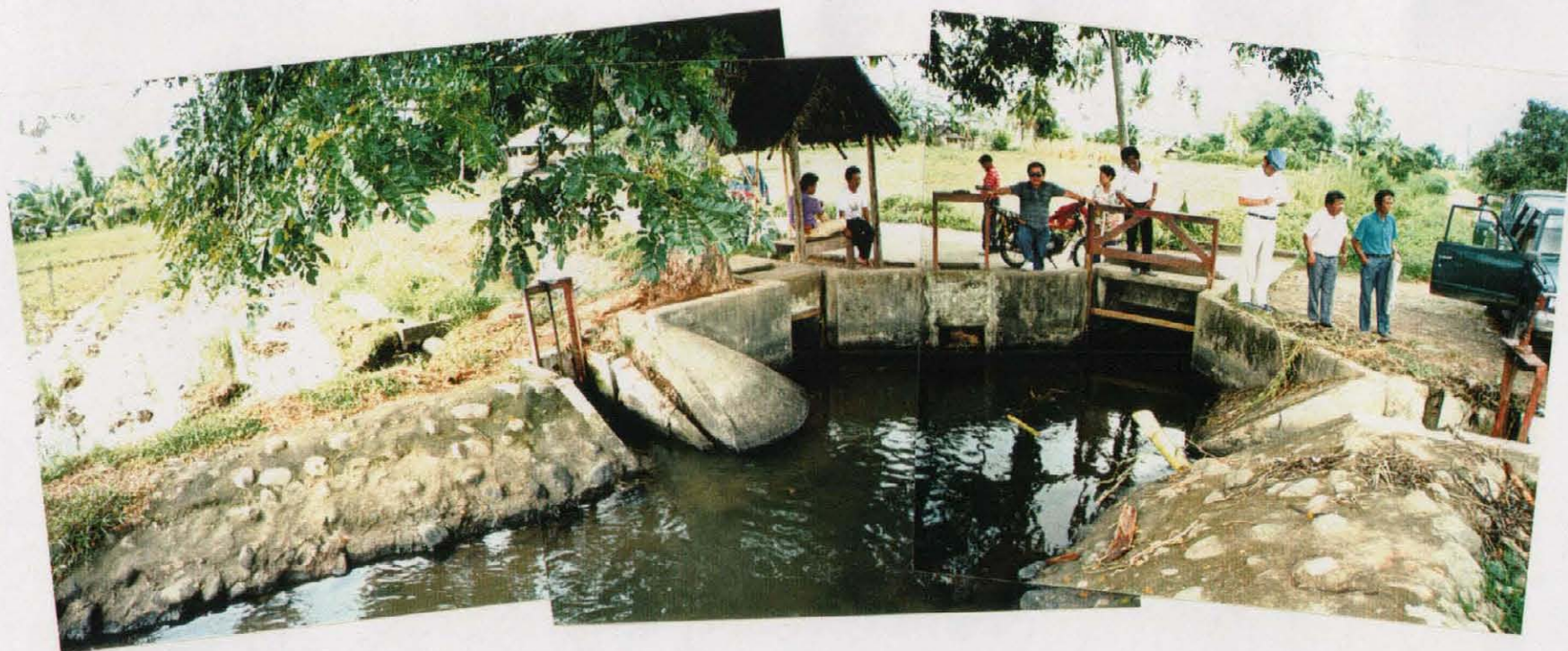
Tibak 川国営灌漑システムの水利施設
