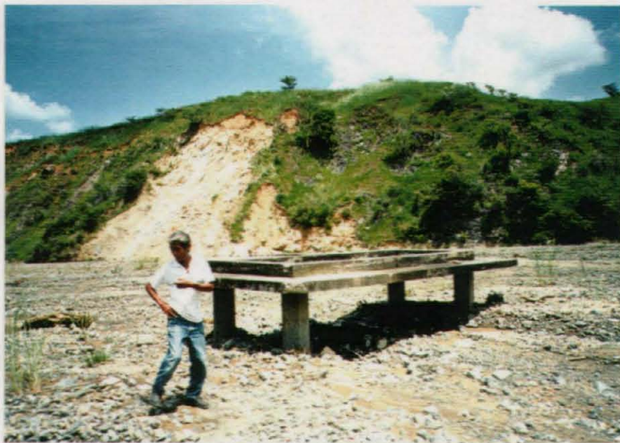
1990年ルソン中部地震の土石流で河床が10m上昇し、完全に埋まったディパロ灌漑システムの頭首工（土砂崩れした山肌が見られる）
