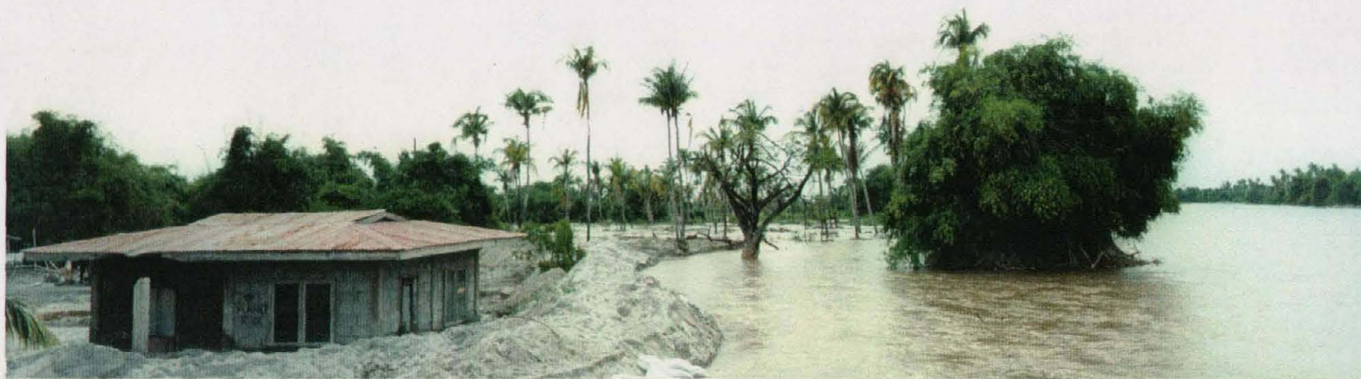
ピナツボ噴火による泥流(Lahar)の 影響を受けた Jalakak川 (Cabangan県)
