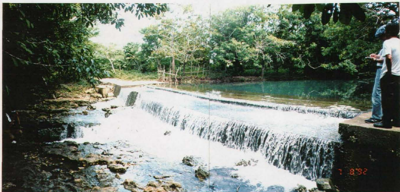
Bani県内で既存の泉(Basay Spring)を利用した アルリス・マシーテム小規模灌漑施設
