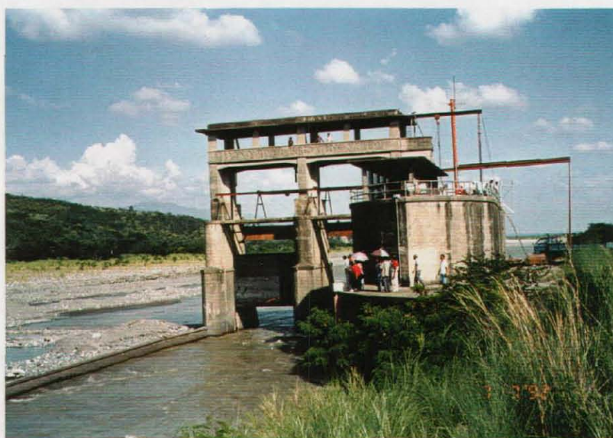
アゲノ川灌漑システムの取水堰（河川流水が上流 鉾山からの廃液により汚濁している）
