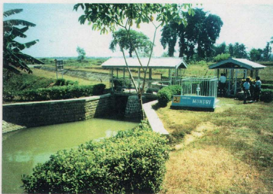
Mundri堰の沈砂池から 幹線水路の起点
