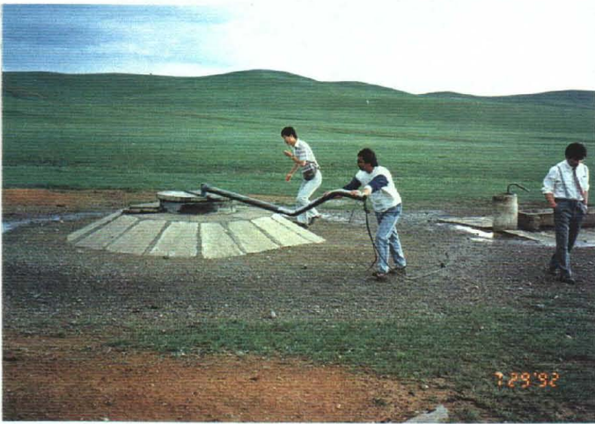
スパイラルポンプによる 浅井戸揚水
