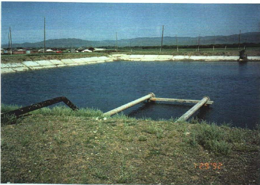
かんがい用地下水温水化ポンド
