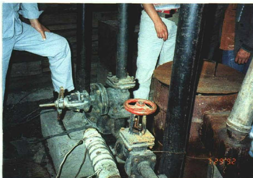
深井戸水中ポンプ (ニクロム線ヒーターがある)
