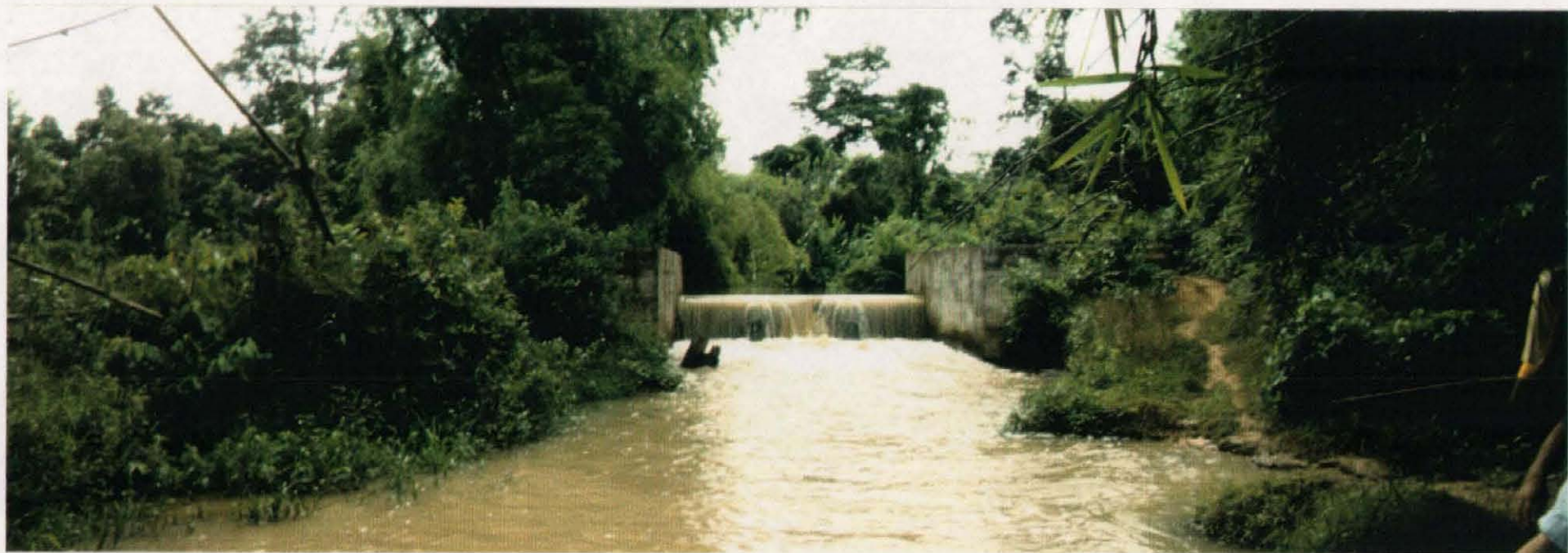
地区内に建設されている取水堰
