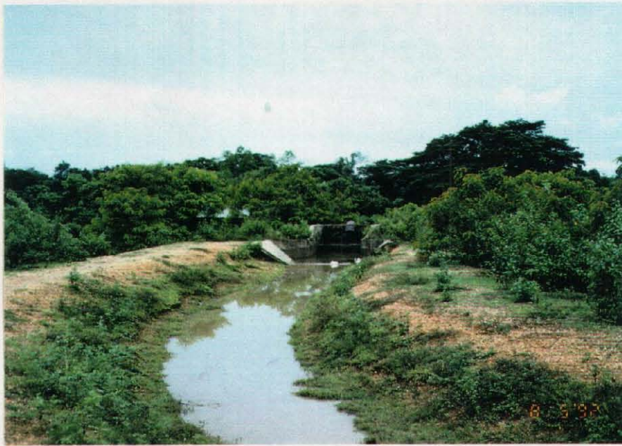
タットマラ ポンプ・ステーションの受水槽と運河の状況
