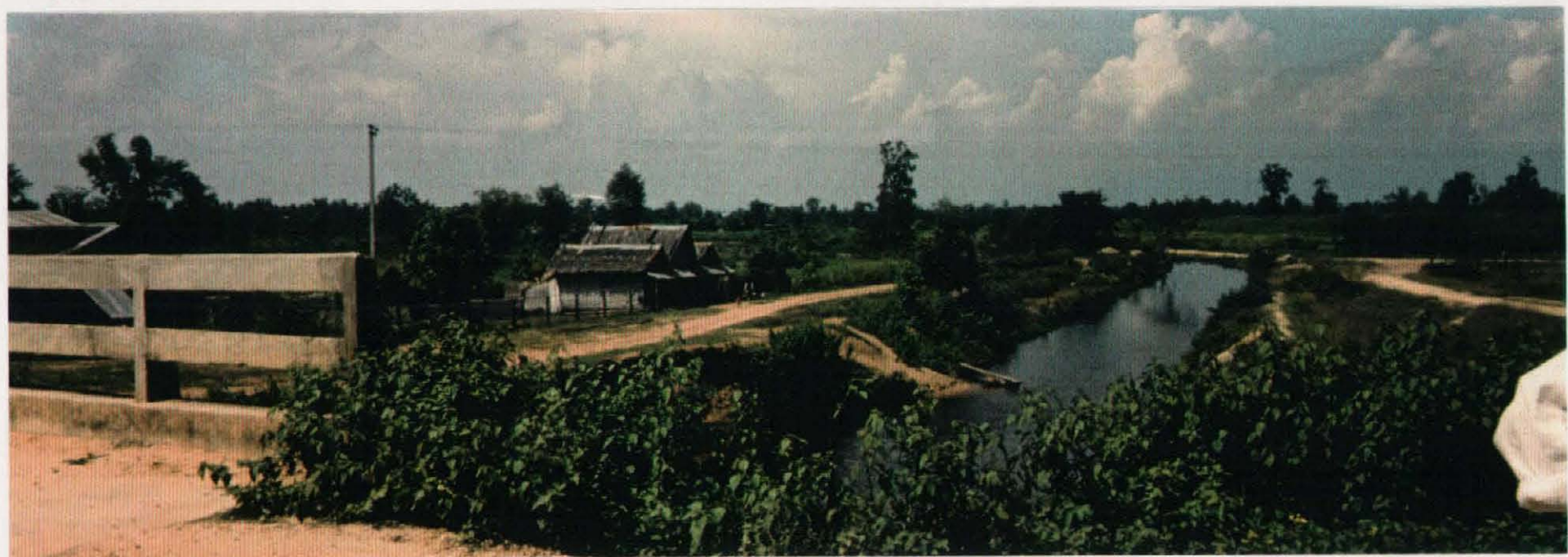
建設途中の幹線水路（2）
