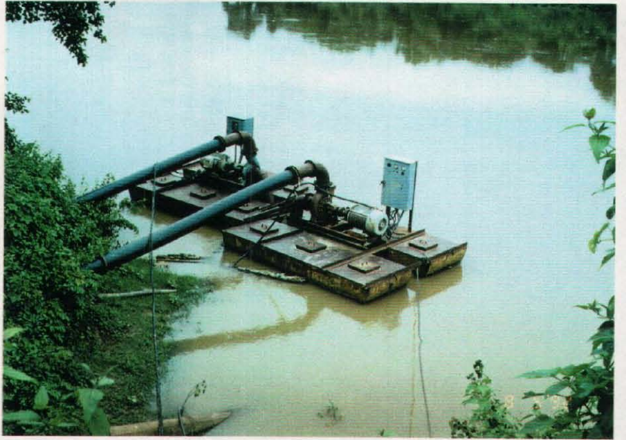
タットマラ ポンプ ステーション
