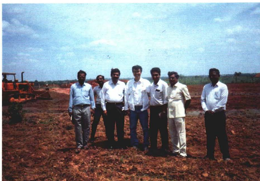
アンドラプラデシュ州 農地開発工事現場視察
