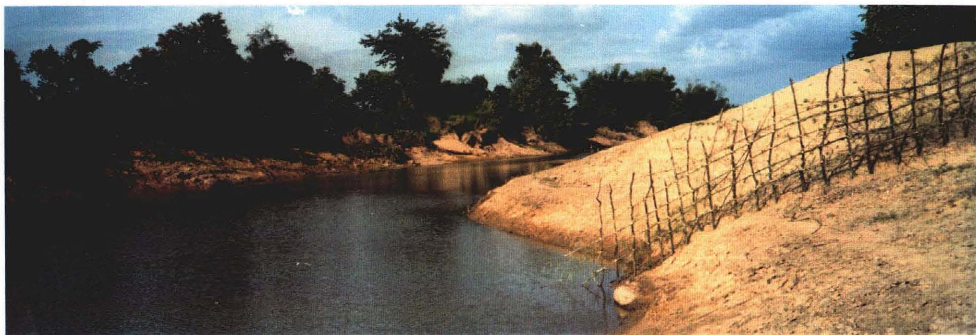
パリン地区：パリン川合流部の状況（下流側を望む）
