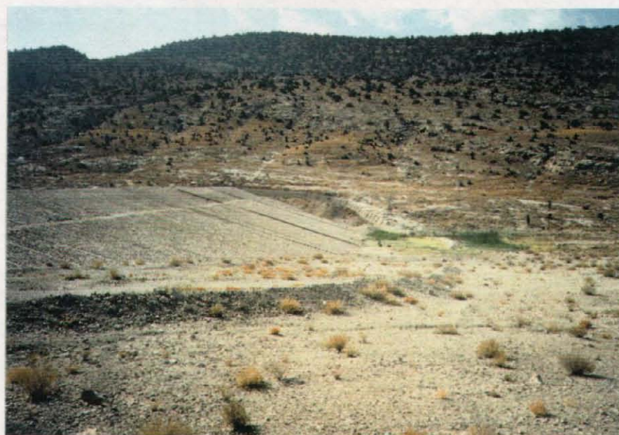
Pechi Damの下流面
