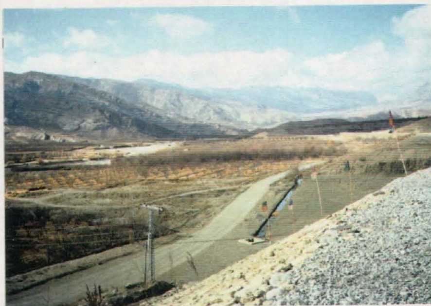
Werchume Delay Action Damにより 開発されたリンゴ園 （右手前はダムの外法面）
