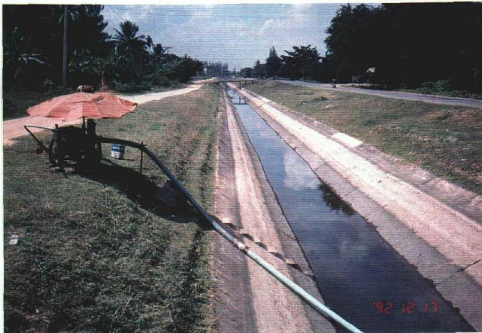
渇水によるかんがい用 水路の水不足状況 (ポンプによる緊急取水)
