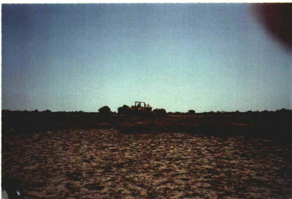
ブルドーザによる土工事
