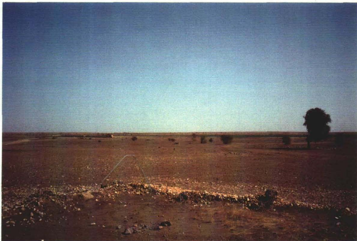
イタリア援助によるダム建設現場
