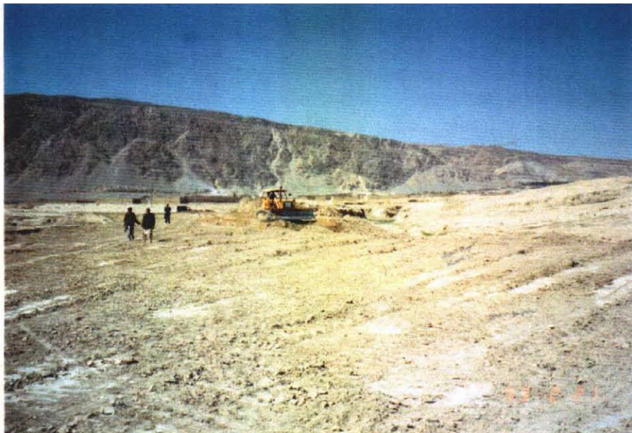
ハンナ川沿いの 開墾造成工事現場 (林檎を植える予定)
