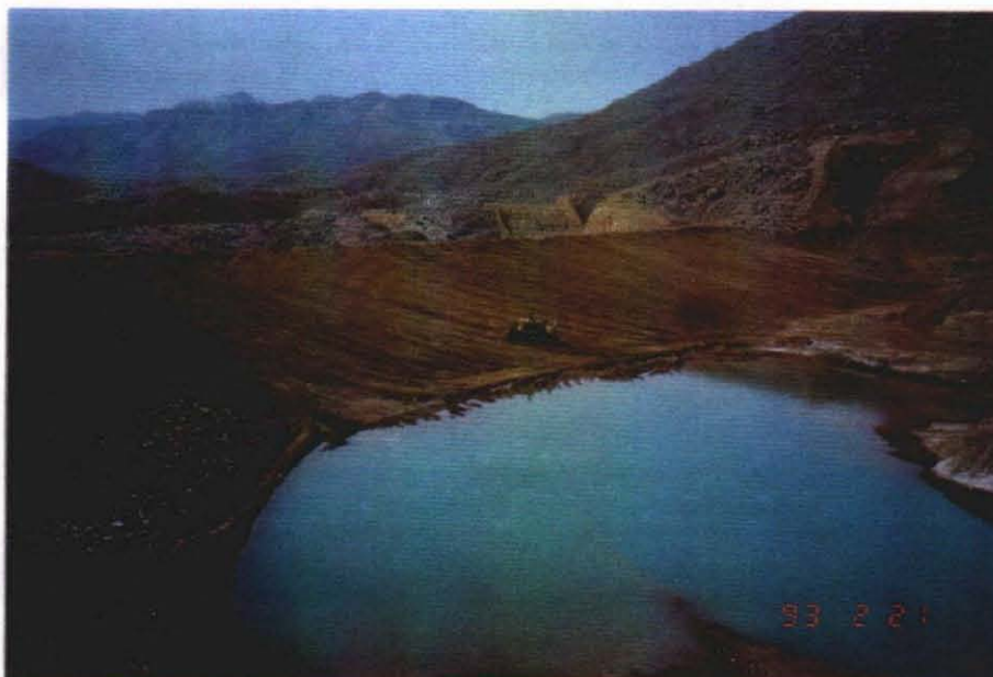
ハンナ川より上流 に造成されたミニ ダム。
