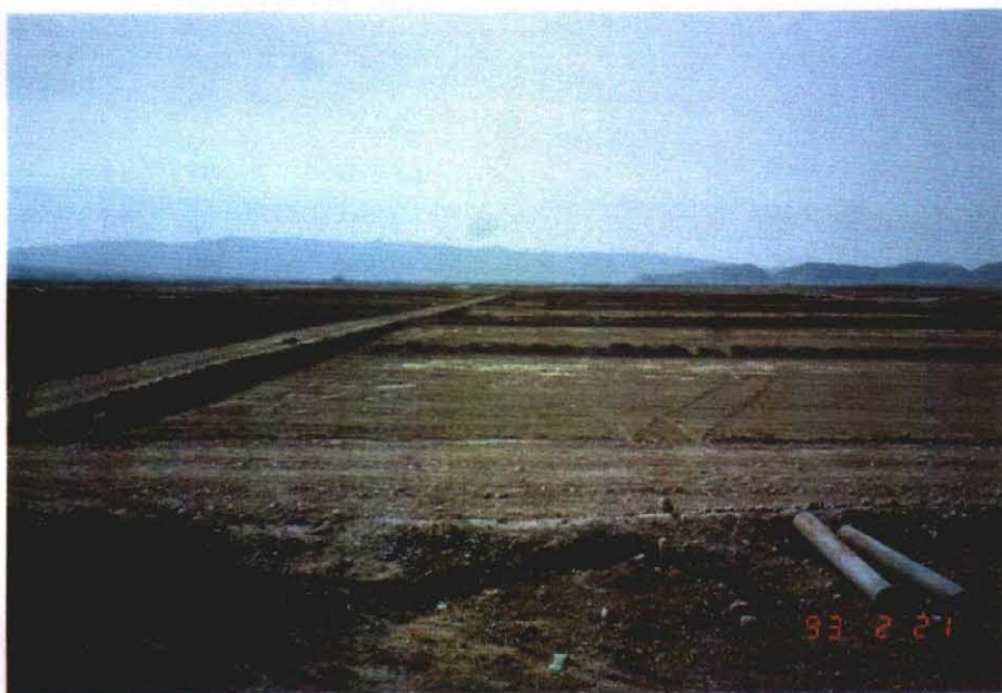
地盤を掘下げる 工事が完了した ところ。
