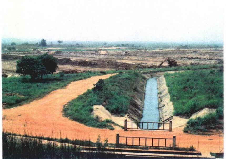
(2) 既存小規模灌漑事業 (アフイフェ) (幹線用水路/フィッシュポンド 造成風景)
