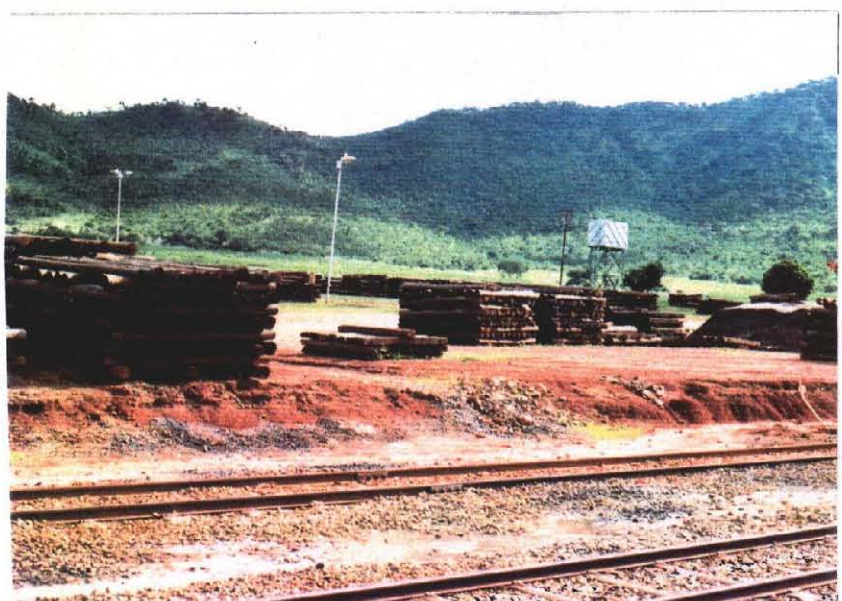
(2) ビンドウラ穀物サイロ建設予定地 (建設予定地)
