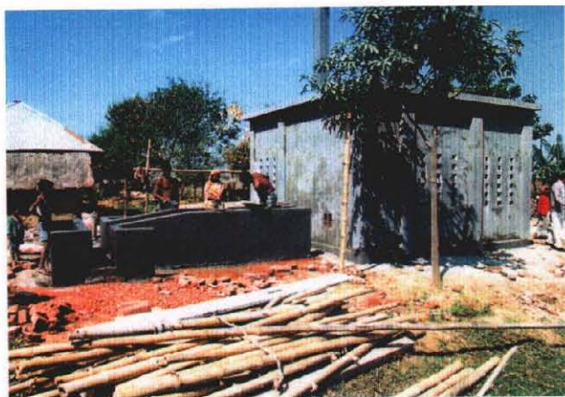
建設中のDTWステーション
