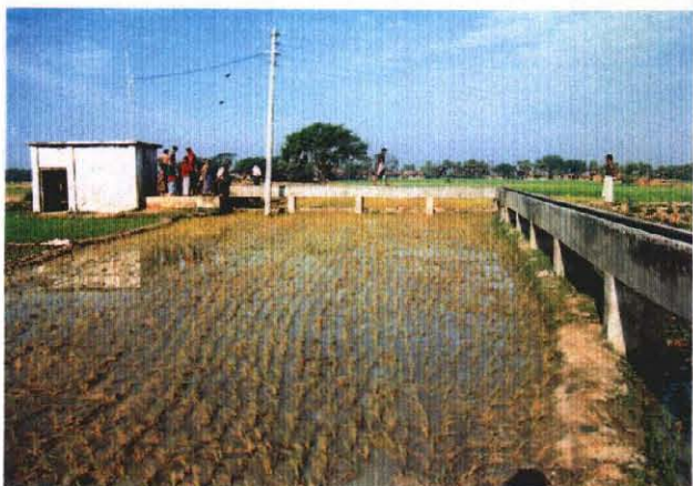
電化されたDTWステーション（ディーゼル／タービンポンプから電動／水中ポンプに置き替え）と、新設された送水路 水中ポンプの設置により、受益面積が増えた
