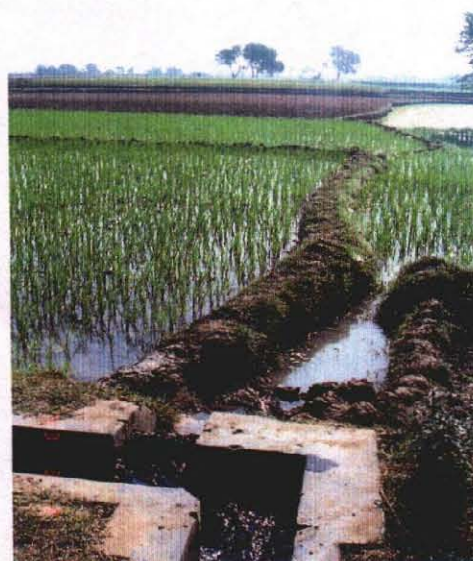
送水路からほ場への分水状況
