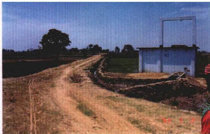
新たに建設されたDTWステーション 送水路は未だ建設されておらず、現在は素堀り水路で運用中
