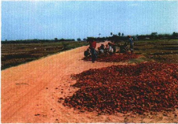
農道舗装工事状況 砂利の入手が困難なバ国においては、レンガを砕き代用している
