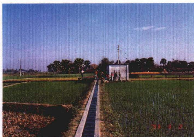
稼働中のDTWステーションと送水路
