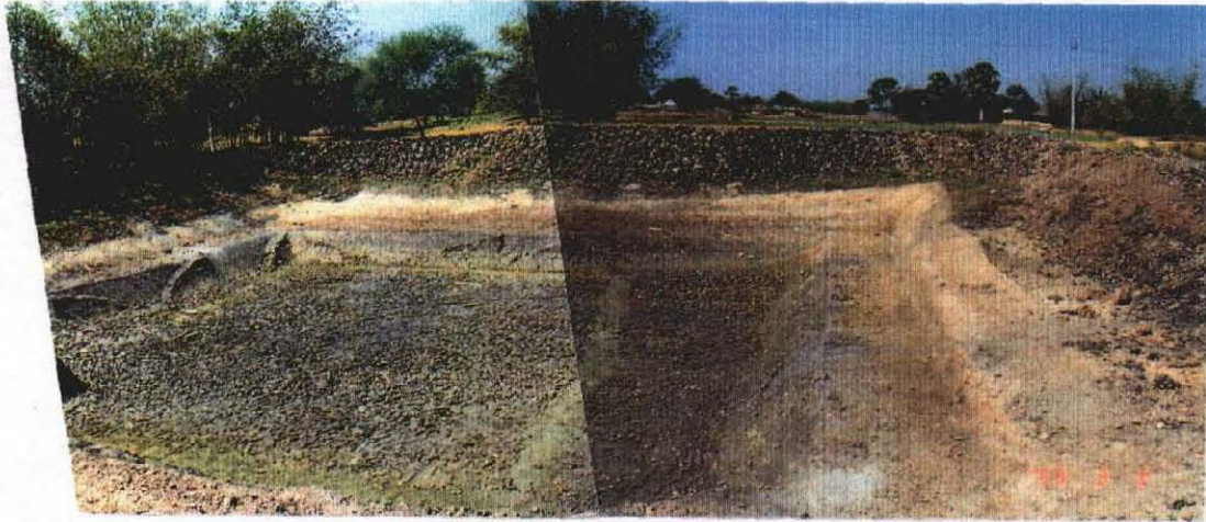
乾期の間に行なわれる溜池の再掘削 対象となるのは、公有の溜池
