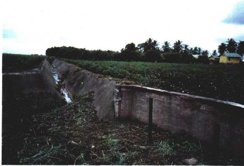
幹線水路既設接続部（ティカソル地区）
