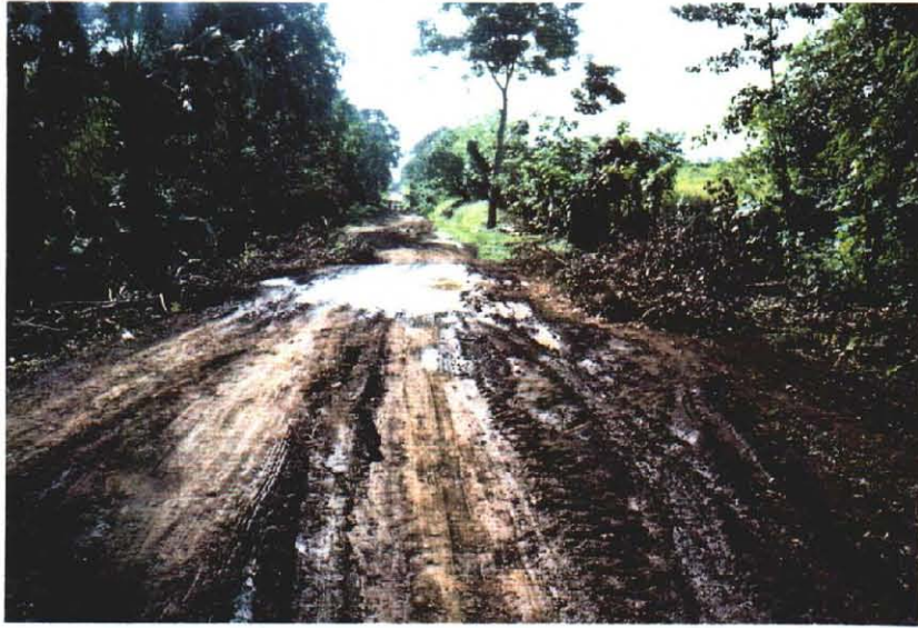
支線農道の損傷状況
