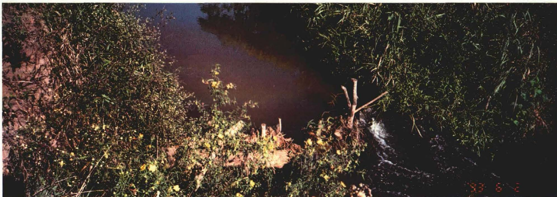
ミシオネス県中部地域稲作増産計画：木片と土砂で作られる簡易取水堰
