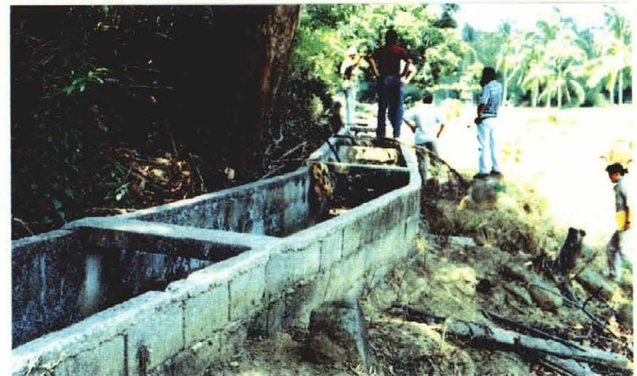
既存灌漑水路。一部ブロック積。乾期であったため水はない。
