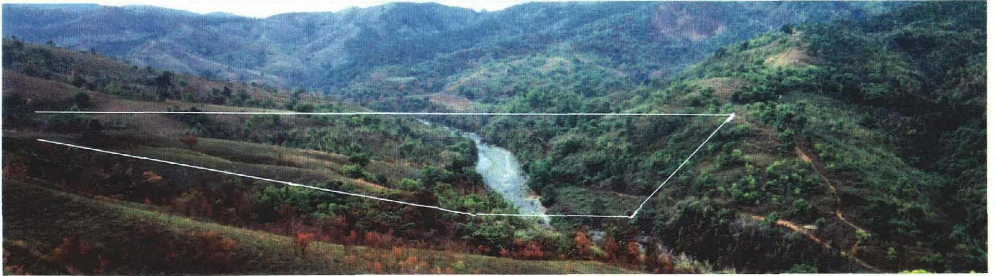
中規模ダム計画地点（図中白線はダム盛土（H = 50 m）を表す）。
