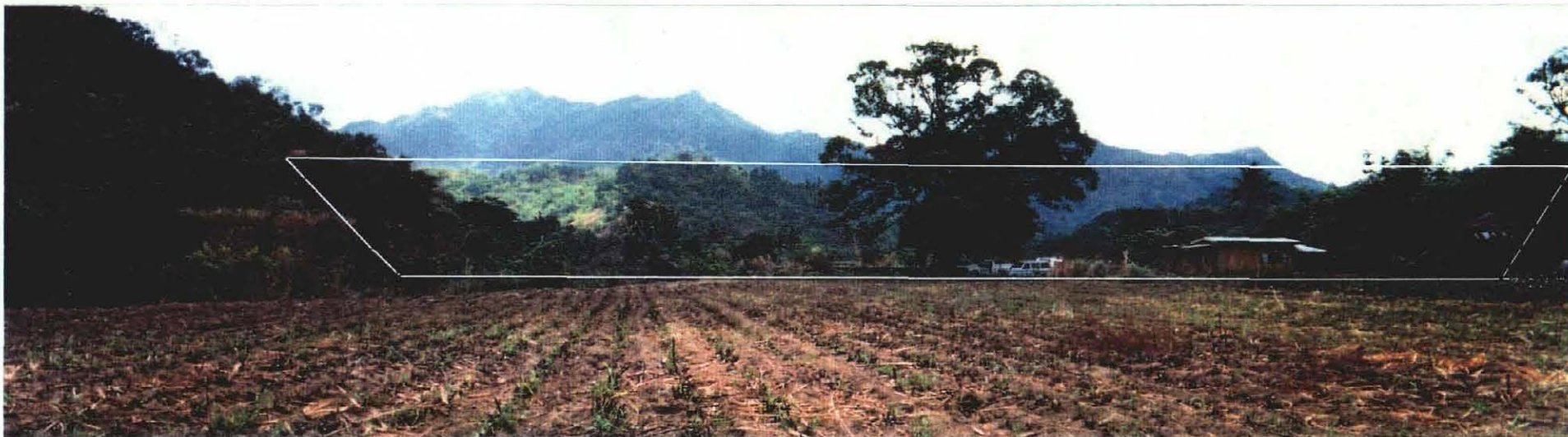
ダム建設候補地点。写真中央に既存の取水堰がある。
