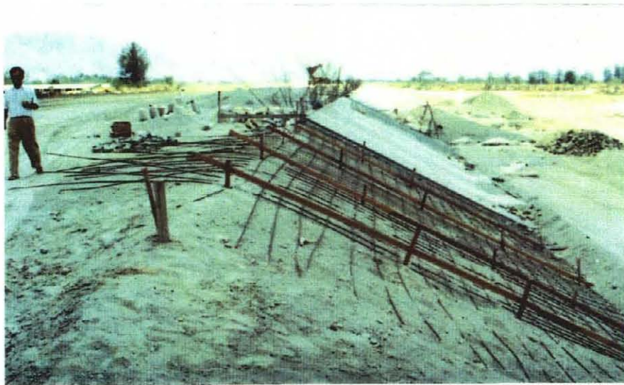
建設中の堤防。コンクリート製。高さ約2 m。
