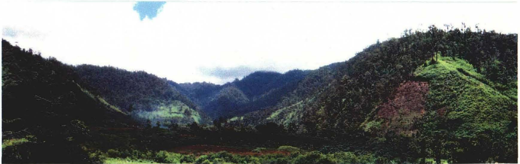
取水堰建設候補地河川の流況（渇水期ではあるが、毎秒約3トンの河川水が確認できる）。 （カミリン地区）
