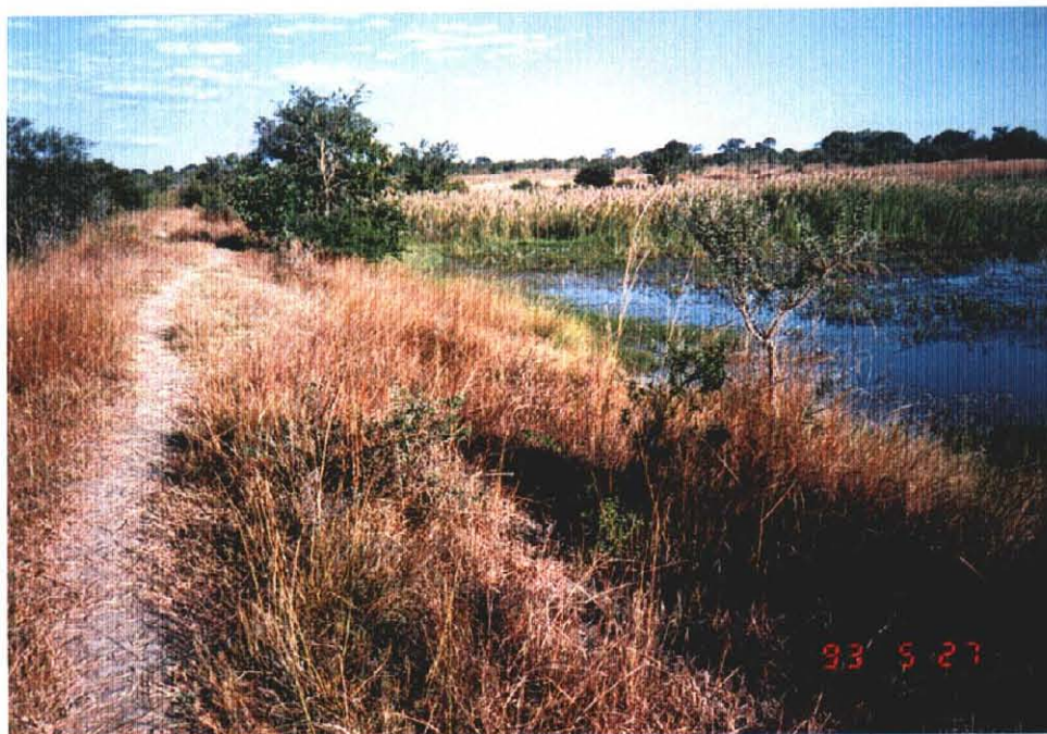
ルサカ近郊小規模ダムの堤体の状況
