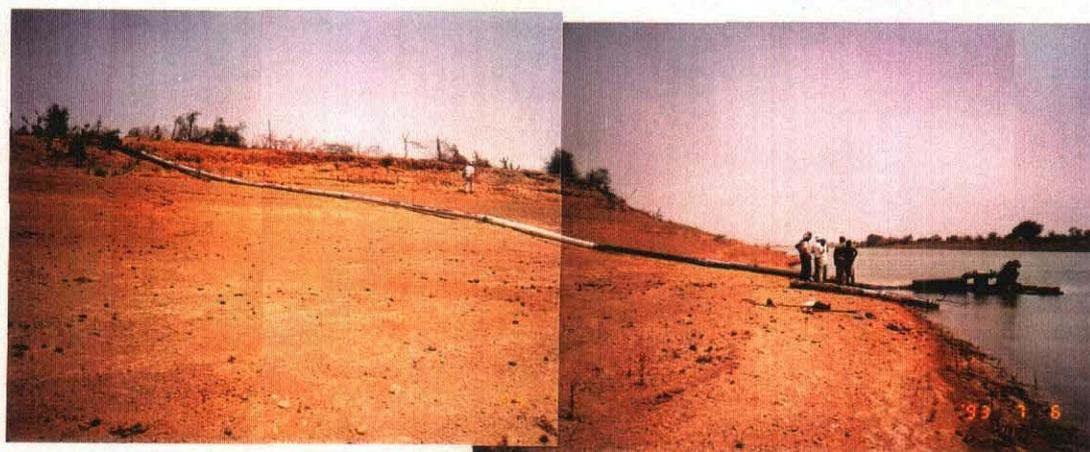
稼働しているフローティングポンプと送水管、川はドウエ川 (Mboumba)
