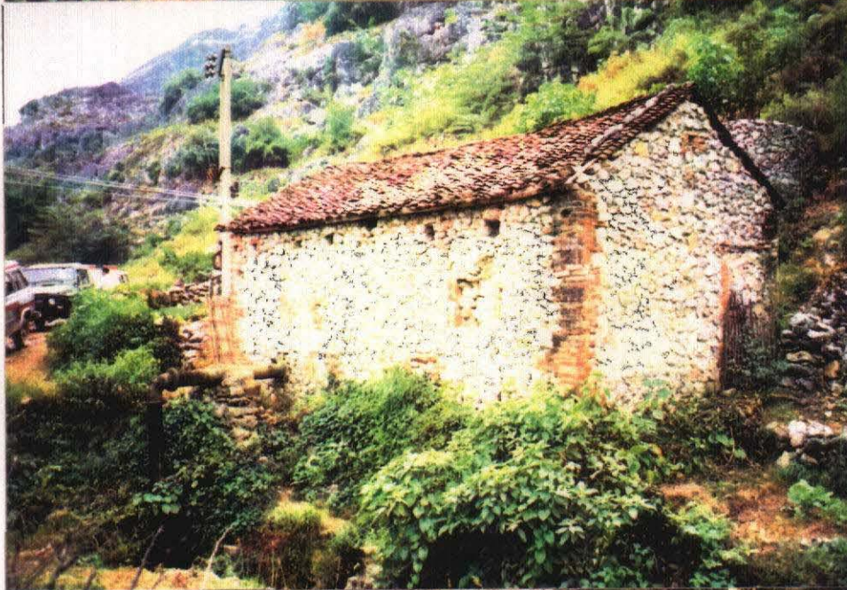
幹線用水路からのポンプ場 老朽化により能力は半減 (槐前村)
