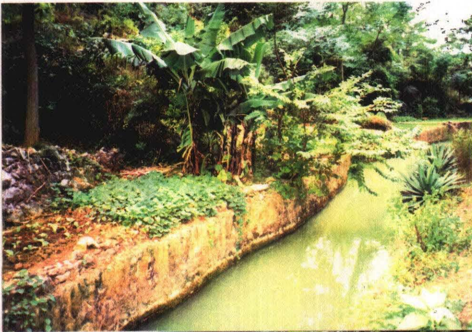
幹線用水路 石灰岩を使用した石積 (槐前村)
