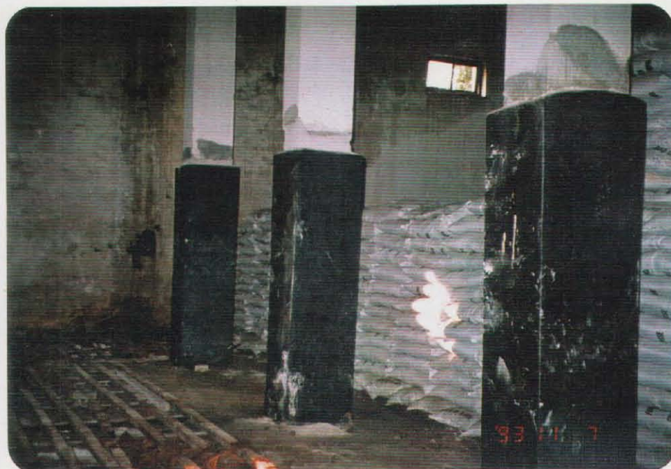
Bhutan Devi 肥料倉庫 における肥料によるコン クリート及び鉄筋への 影響を考慮したコン クリート柱の施工状況。
