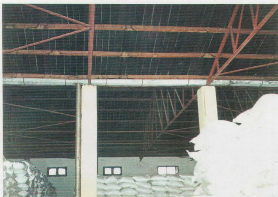
同上倉庫における2ユニット の接合部の雨樋の設置状況。
