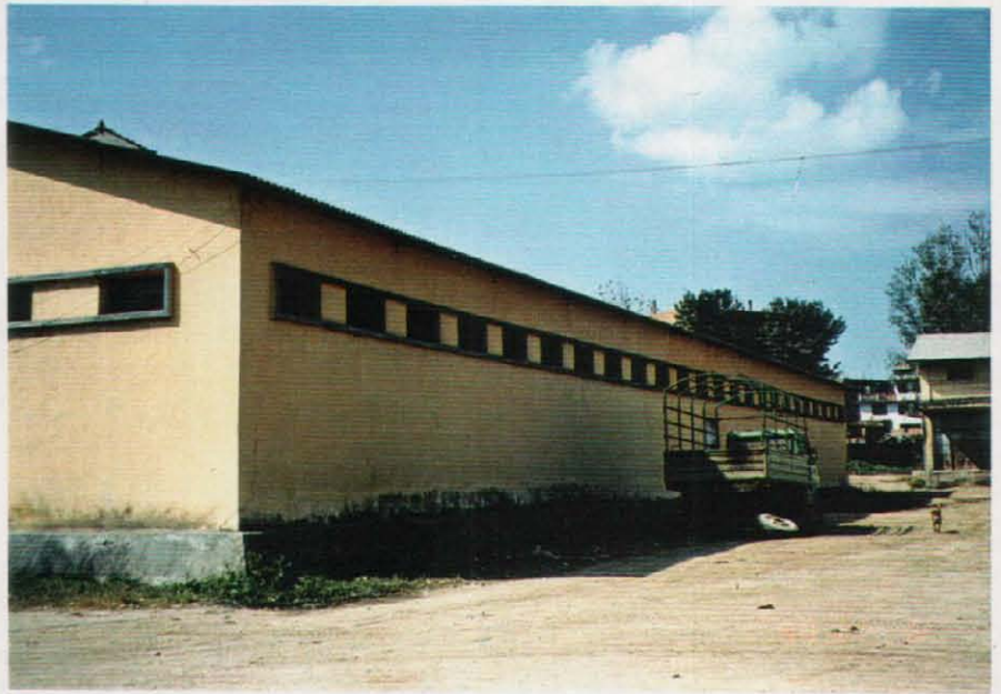
カトマンズ市内のA I C 本部の傍にある肥料倉庫 (長さ約40m、幅約13m)。
