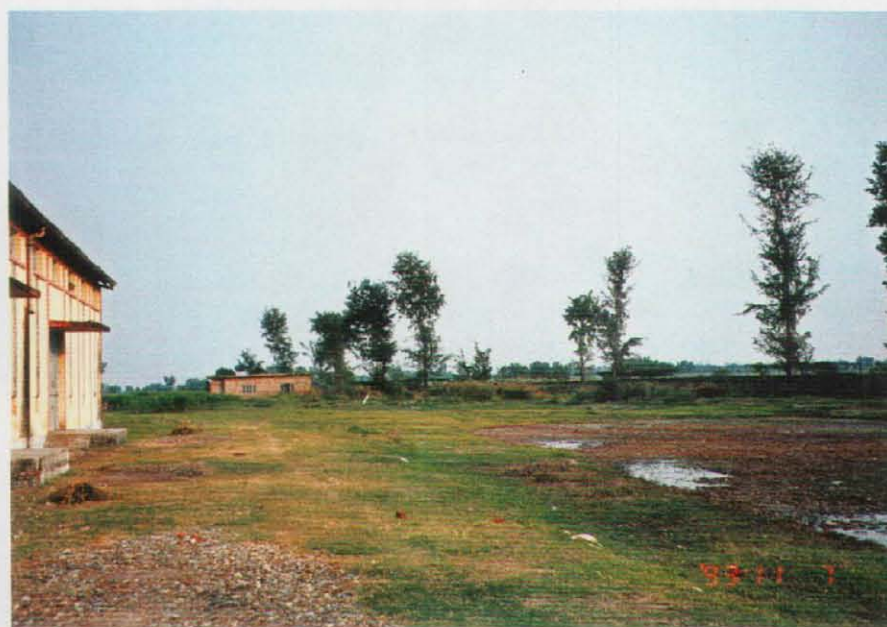
Kalaiya 肥料倉庫の 状況。 遠くに敷地の境界を 示す立木及びコンク リート壁を望む。
