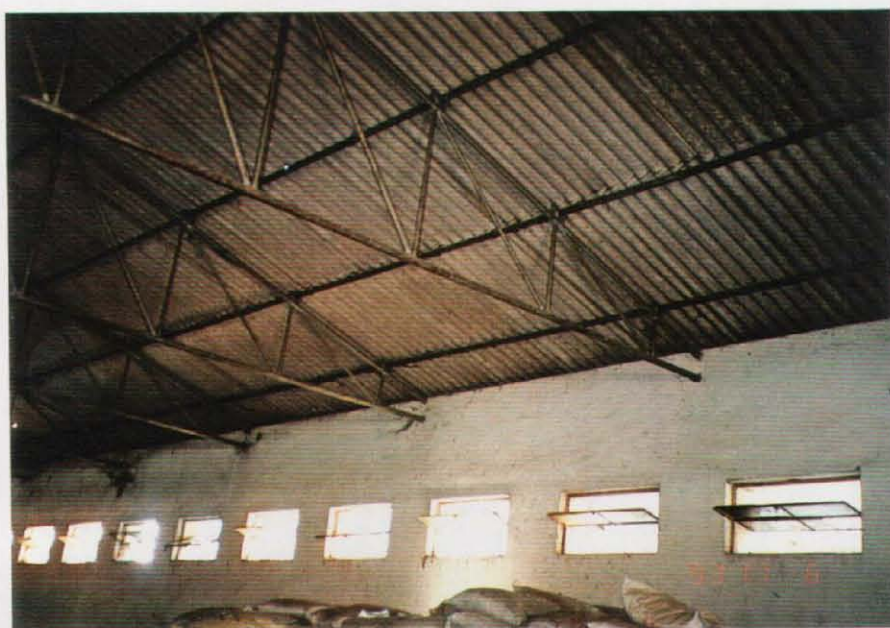
他の倉庫における異なった 屋根の内部状況。
