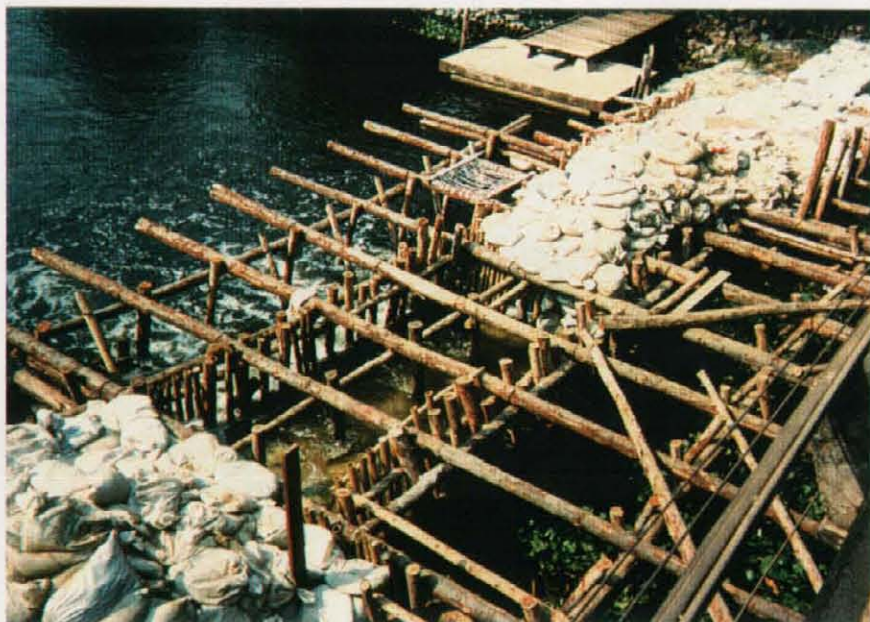
Khlong-Chindaに設けられた防潮堤（河口より約52km、改修中）
