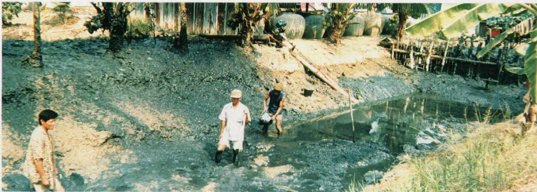
真水集水用の池の掘削（河口より約20km地点）
