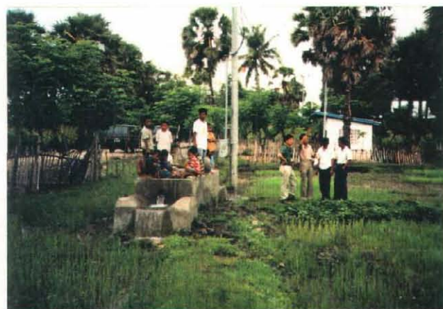
完成した地下水かんがい施設 '95年水利 組合利管予定 JENEPONTO地区
