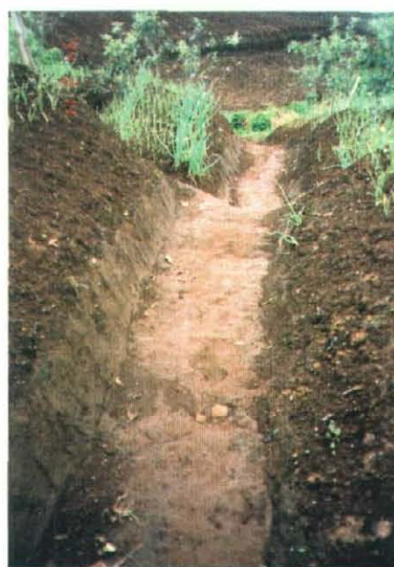
圃場内の、通路兼集水路。基盤部まで掘り下げ、 浸食を抑制しているが、末端部は崩壊している。
