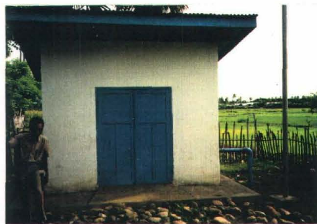
JENEPONTO地区 No.11号井の 揚水施設上屋
