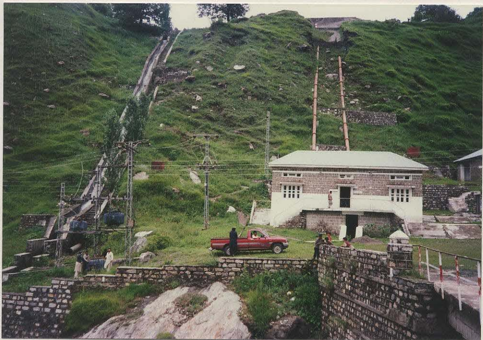
土砂流入により現在は動いていない 既設水力発電所（220KW）
