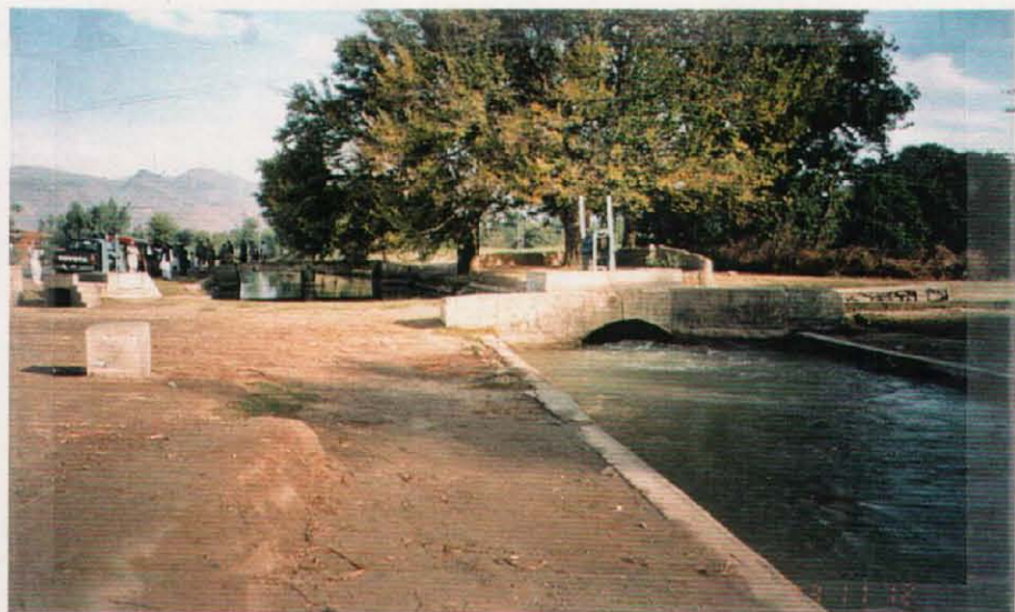
ムンダ地区、右岸幹線水路 (Michani Branch)
