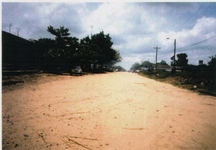
サンカルロス～アントファガスタ間の道路状況
