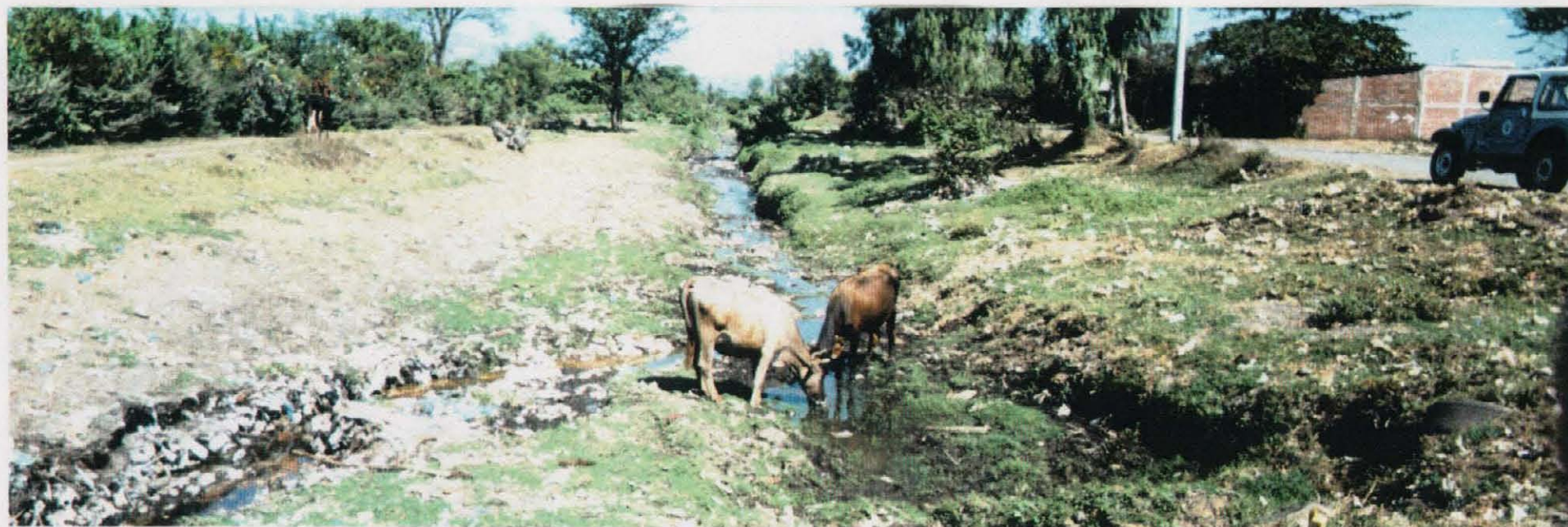
地区内の排水路が埋まり、ゴミが投棄され環境悪化を起こしている状況
