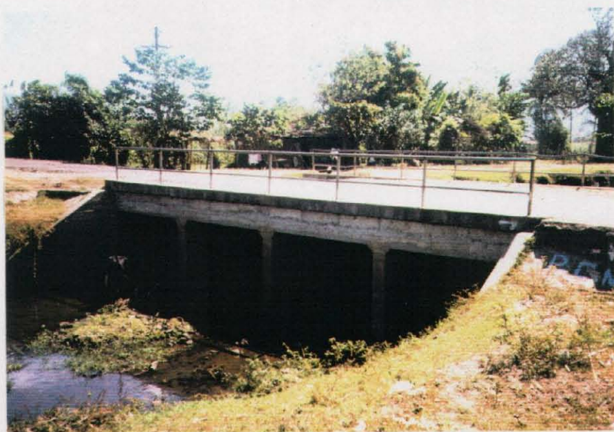
地区内幹線道路にかかる橋梁（上流部で堰にも利用）
