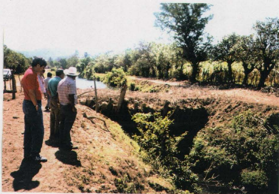
灌漑水のための取水堰（毎年乾期の始めに設置）
