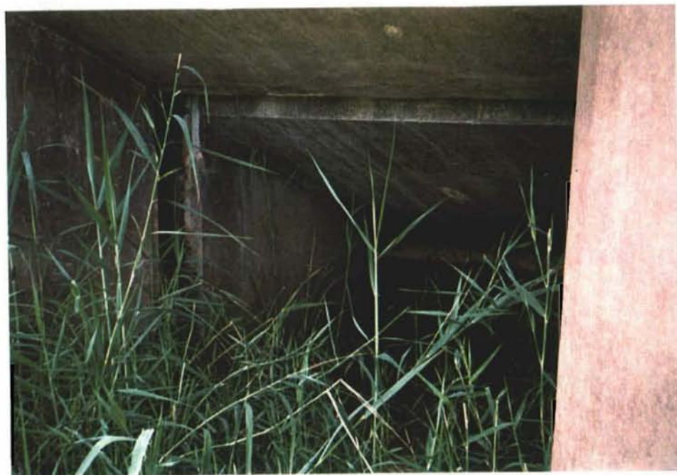
取水塔流入部 (2 連)
