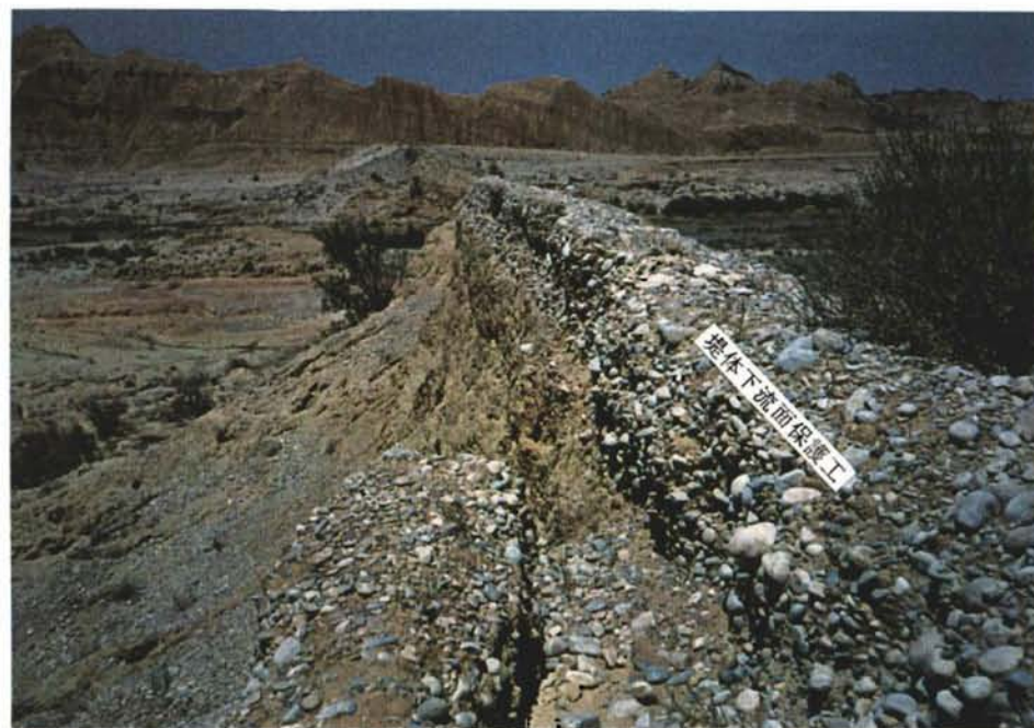
右岸側堤体残存部
