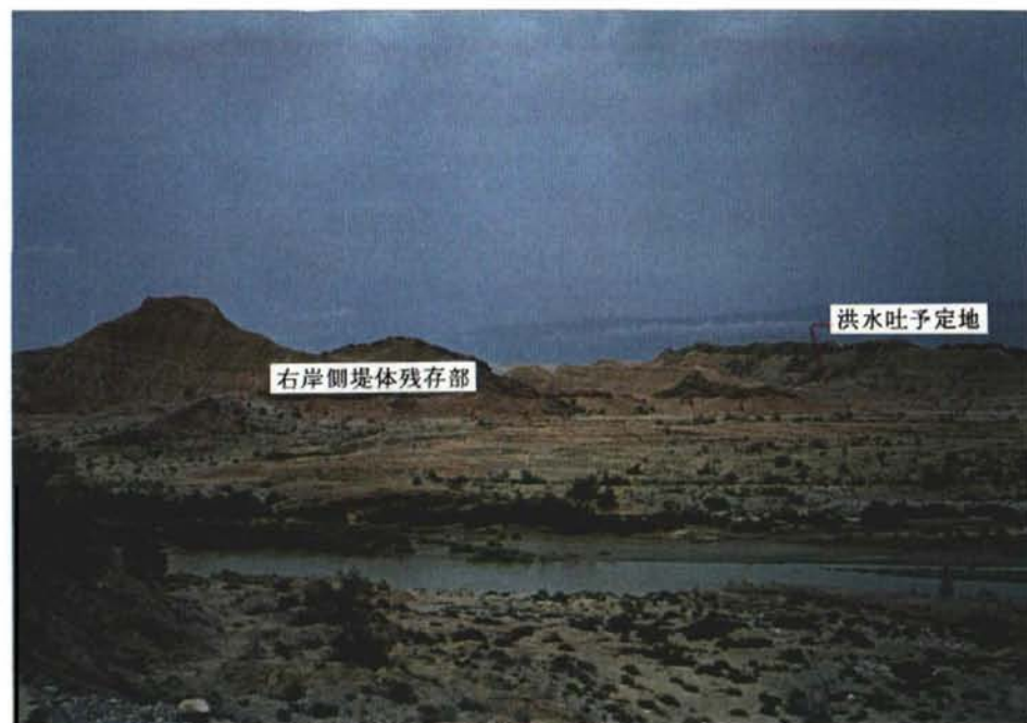
ダムサイト右岸側を望む
