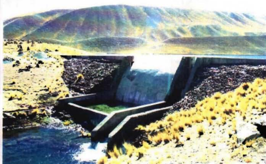
タイピチャカダム 漏水が多く見られる
