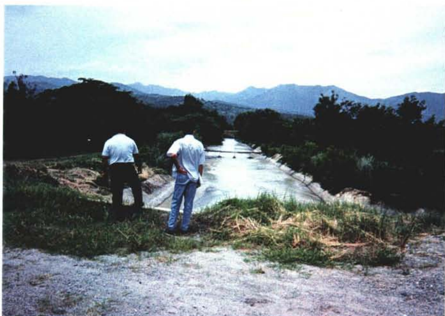
F - 5 Voltex tube 通過後の主水路懸濁状況 (下流にもう一ヶ所Voltex tube が設置されている)
