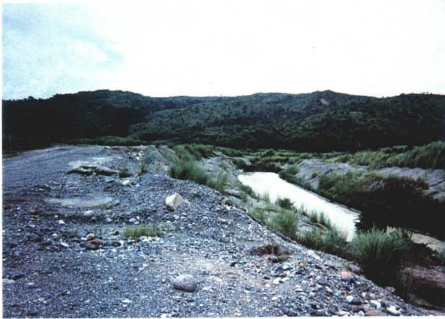
F - 3 導水路上流端付近の浚渫土砂堆積状況 (水路両岸に浚渫土砂が積上げられている)
