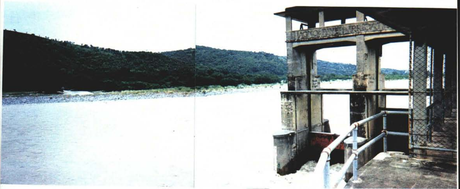
F-1 アグノ川に設置されたARIS頭首工
