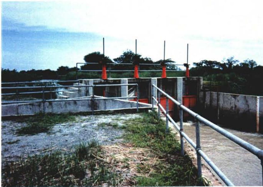
F - 3 導水路上流端付近の浚渫土砂堆積状況 (水路両岸に浚渫土砂が積上げられている)
