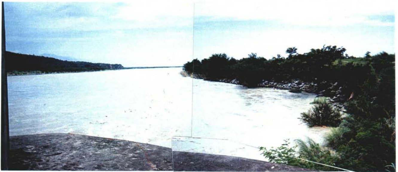
F-2 頭首工下流（右岸側の侵食が著しい）
