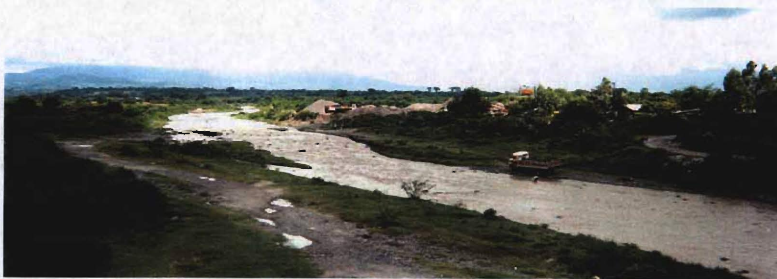
ヒボア川下流部の流況（一部で砂利、玉石採取されている）
