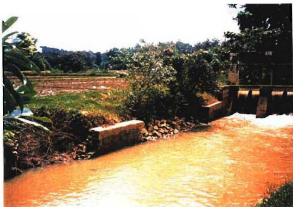
護岸工が破損した Anicut (Hambey Amuna Anicut, Attanagalu Oya)
