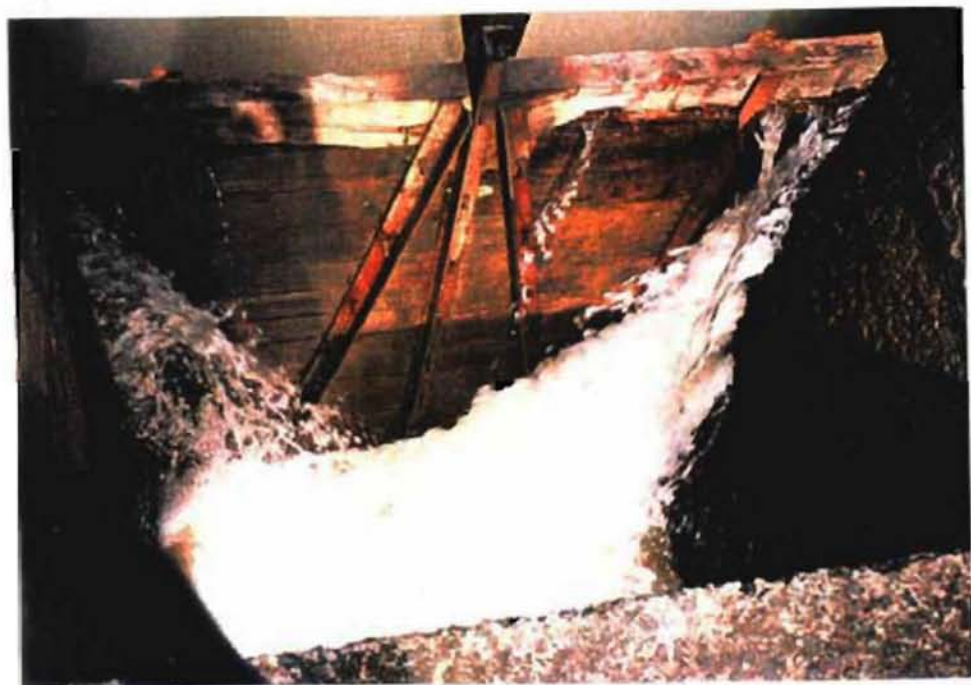
老朽化のため操作不能のゲート (Panugala Anicut, Attanagalu Oya)
