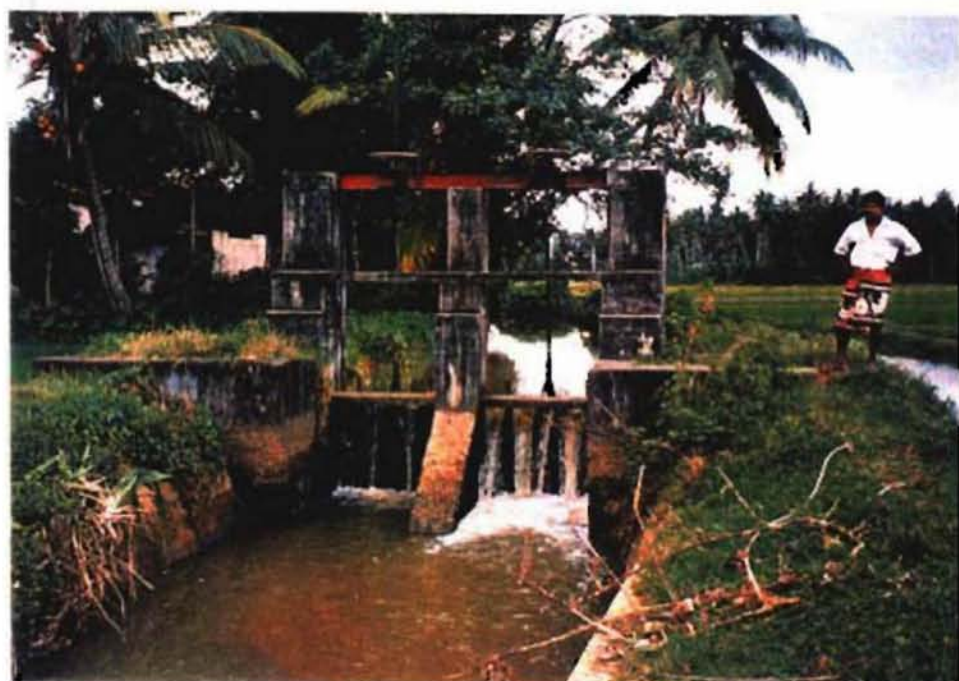
老朽化のため操作不能となったゲート (Gal-Amuna Anicut, Attanagalu Oya)
