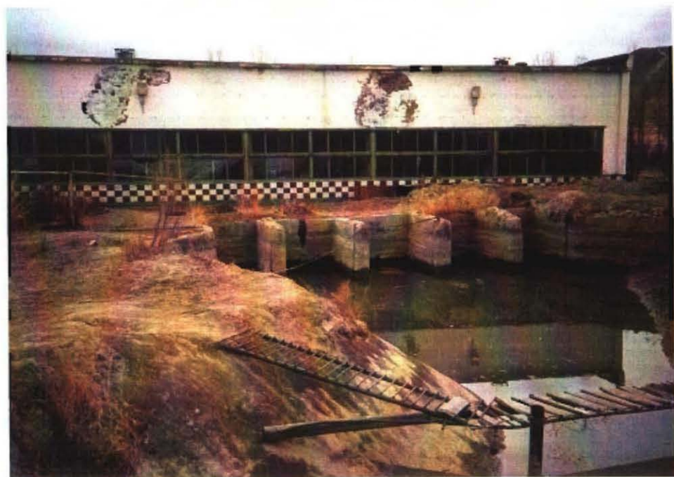
ケネシポンプ場と吸水槽
