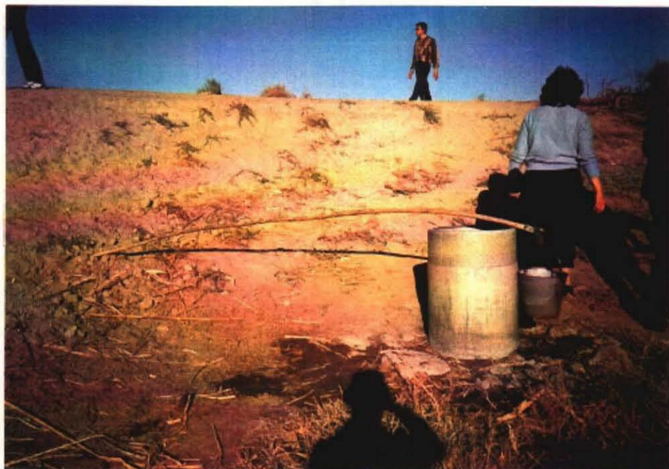
運河の堤防ぞいにある井戸（直接取水している）
