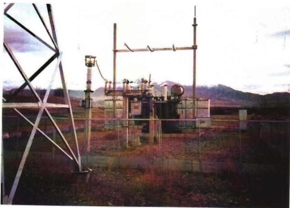
アクジャル I ポンプ場 受電設備
