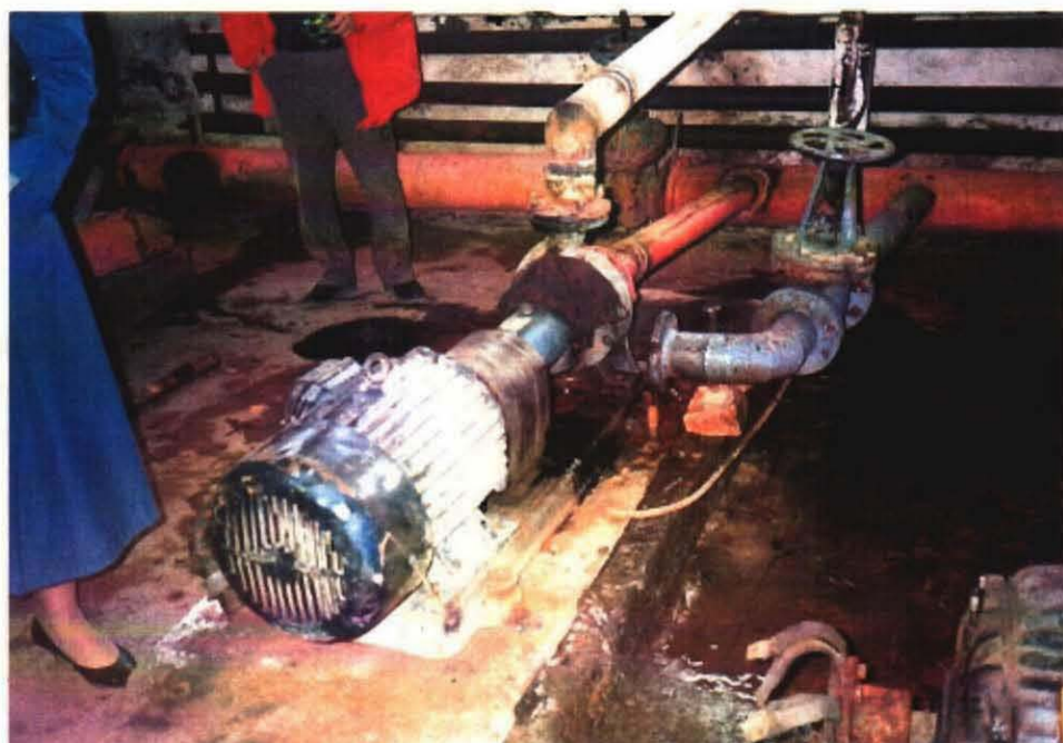
同ポンプ場内のポンプ
