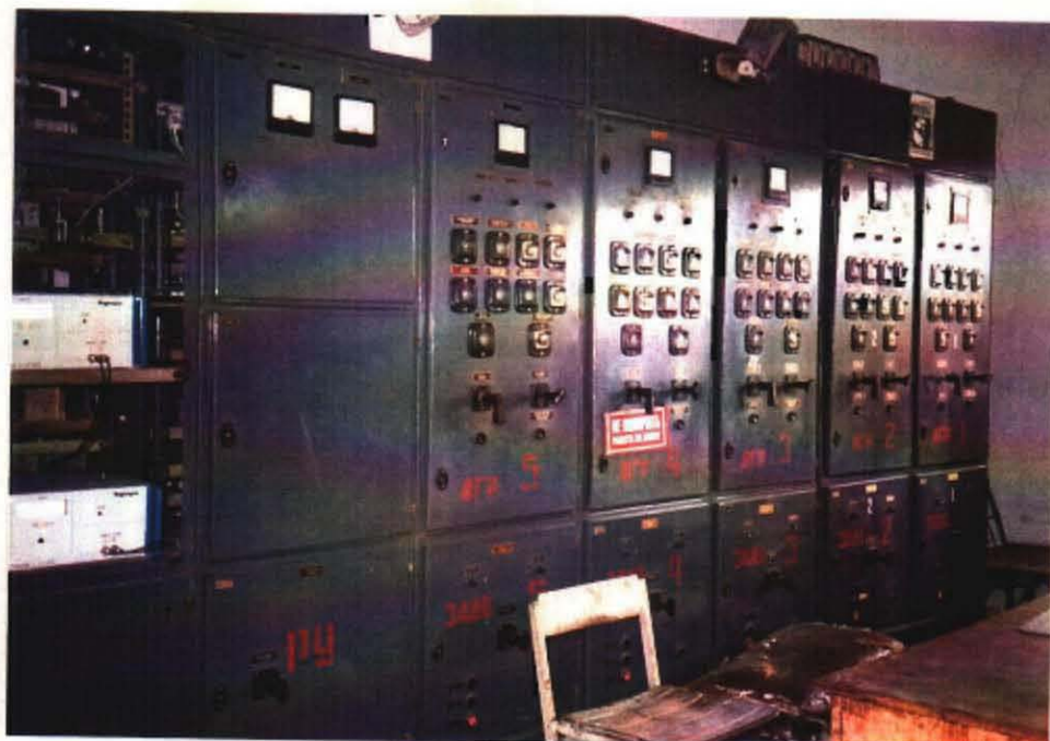
アクジャル I ポンプ場 配電設備
