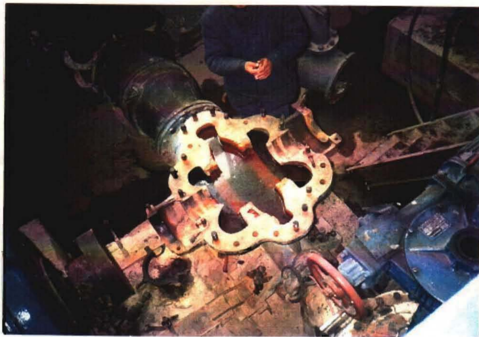
ケネシポンプ場内 修理中のポンプ
