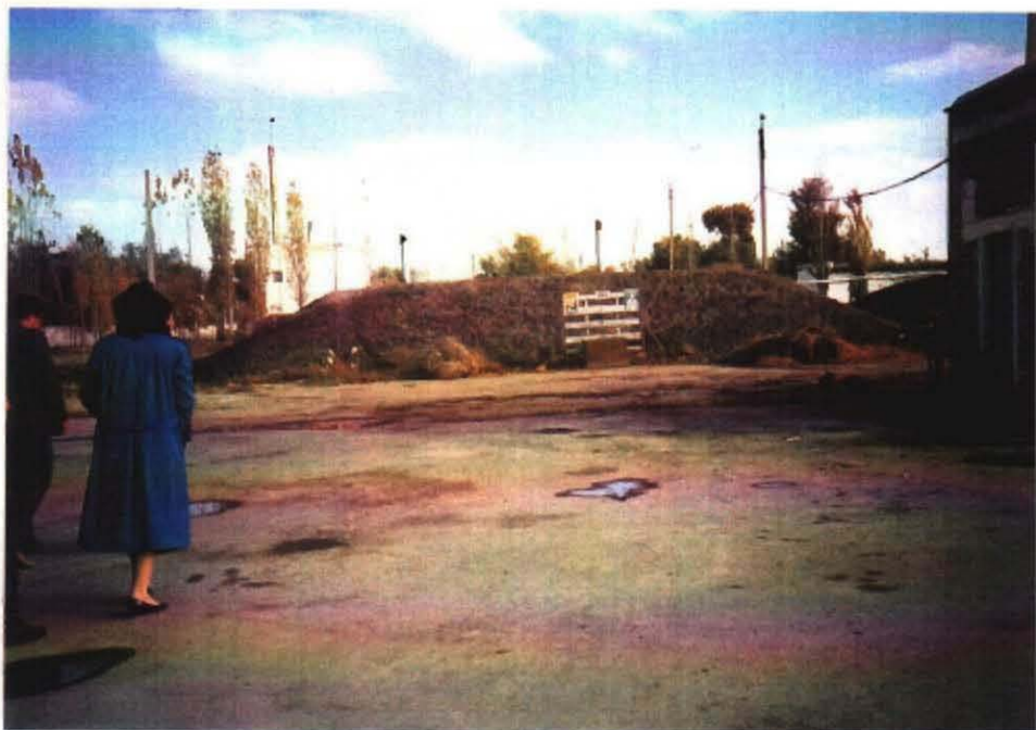
クイビッセフ コルホーズ地区内にあるポンプ場内にある貯水槽
