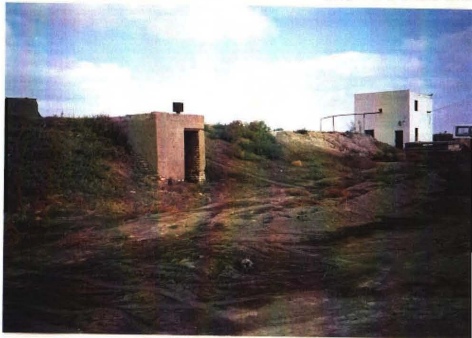
井戸からの揚水後の貯水槽
