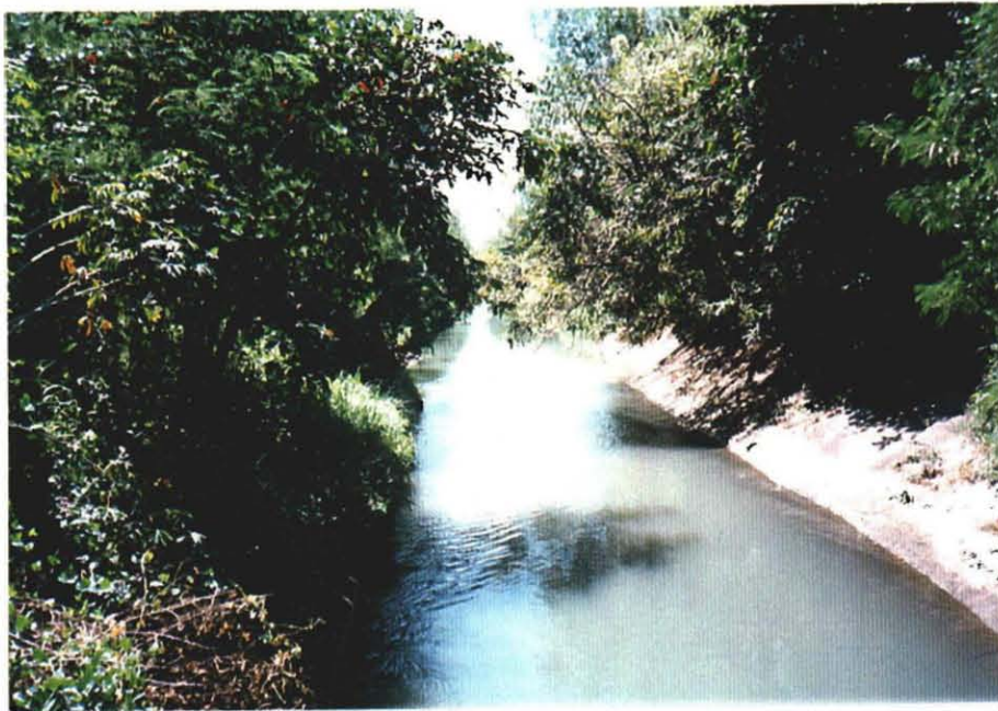
⑩幹線水路 (左岸側、渡河後)
