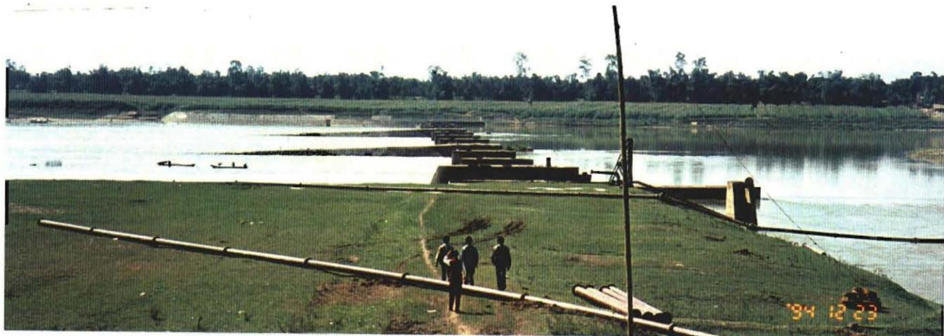
北部ゲ・アン灌溉計画のド・ルオン堰。フランス製転倒ゲート設備。
