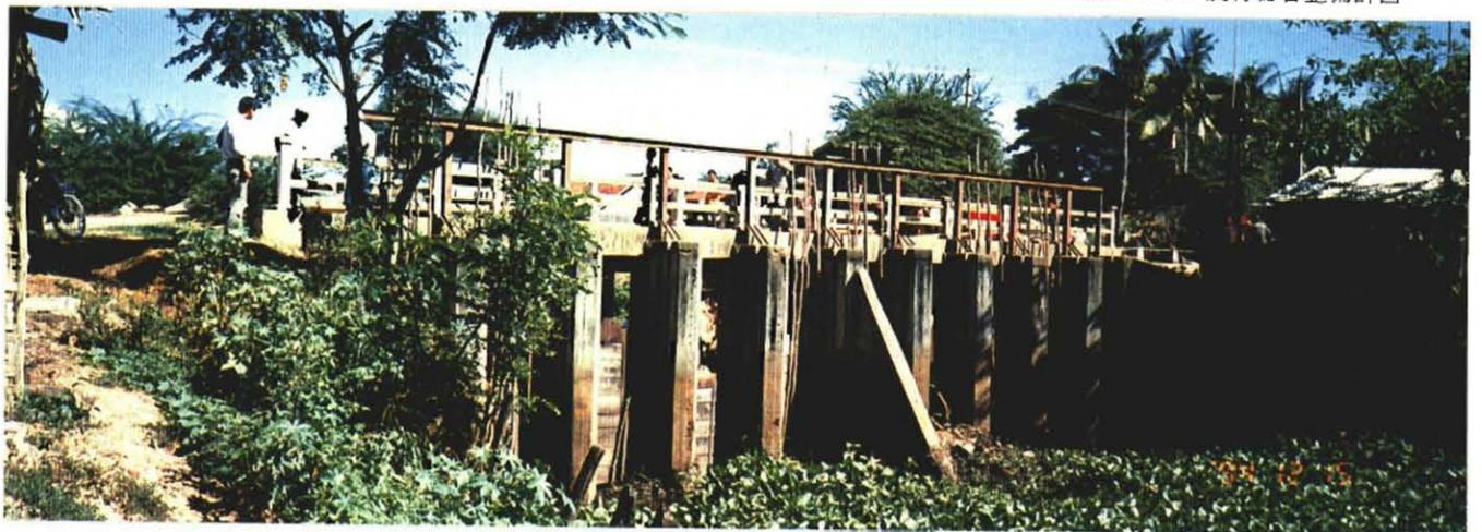
タモック貯水池灌漑計画のブレク・プノウ制水門。下流側が極度に洗掘され崩壊に瀕している。
