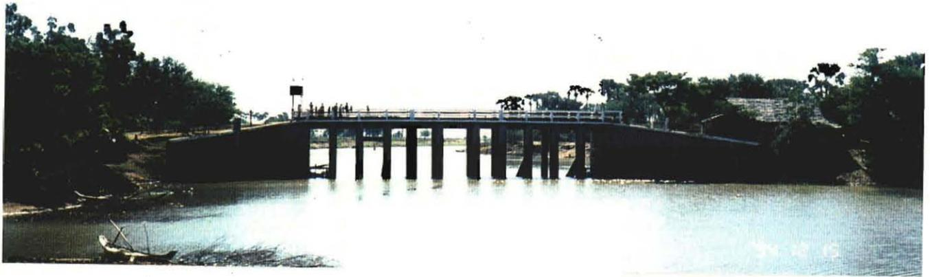
上流側から見たオ・アンドン水門。角落としては喪失している。左岸の水位計は1993年にJICAが設置したもの。
