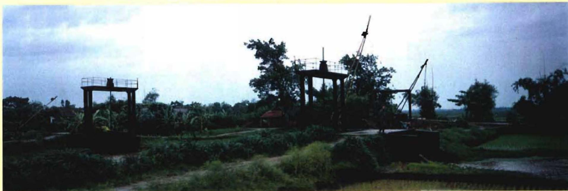
既存の干拓地内にはクリークが多く、水位コントロールのためのゲートが多数ある。
