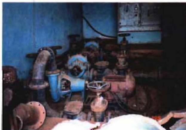
既設No.3ポンプ機場内(稼働不能)
