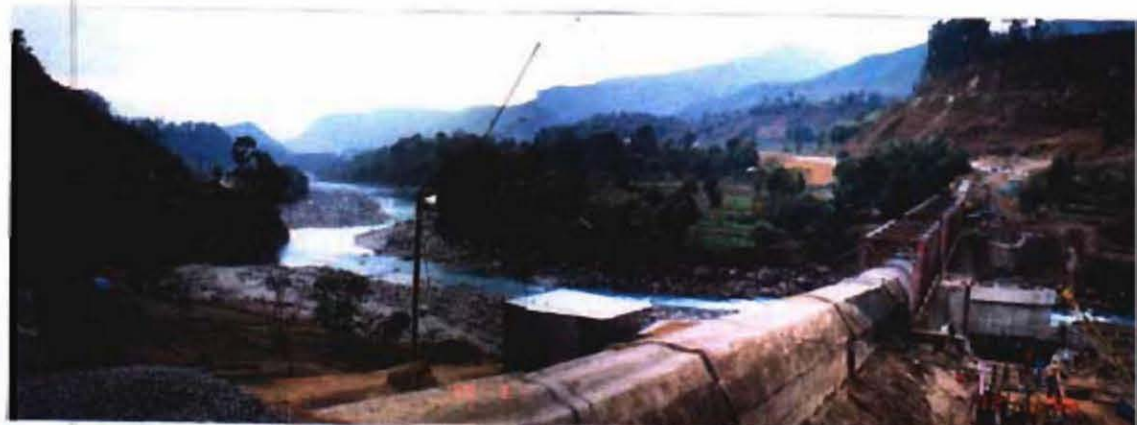
トリスリーデビガット発電所拡張計画(平成7年7月竣工予定) 既設水管橋(約300m)の上流側に増設水管橋を建設中である。
