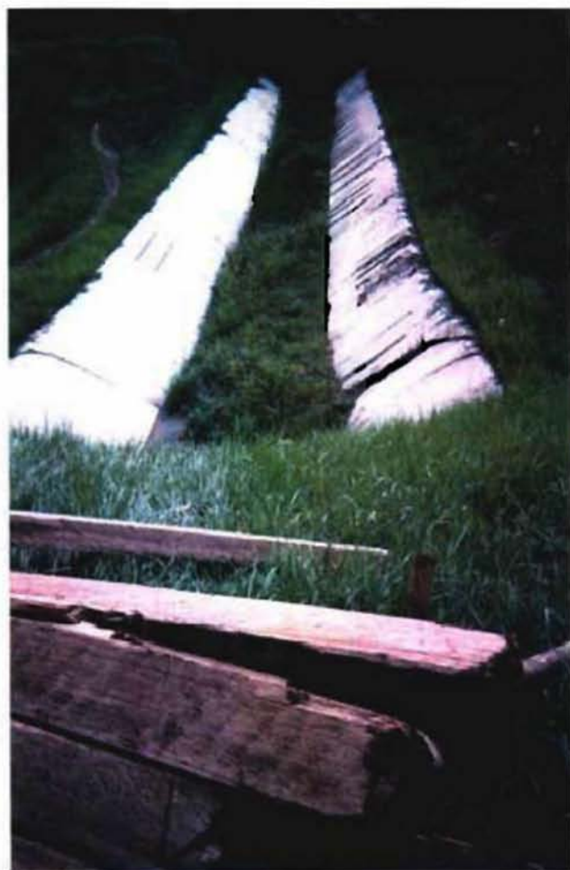
カイテイ頭首工 幹線水路
