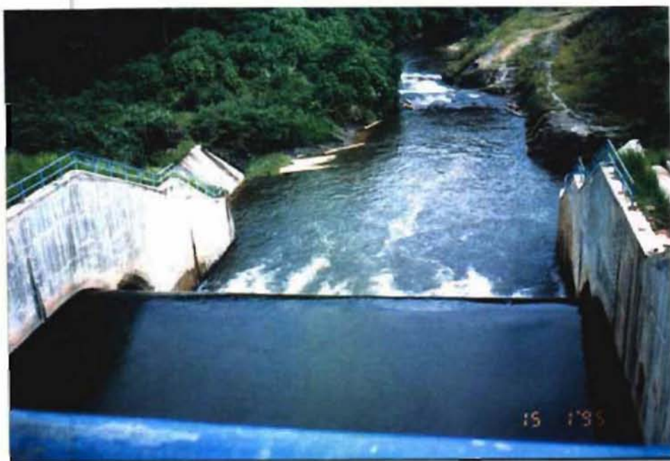
カイテイ頭首工 下流部
