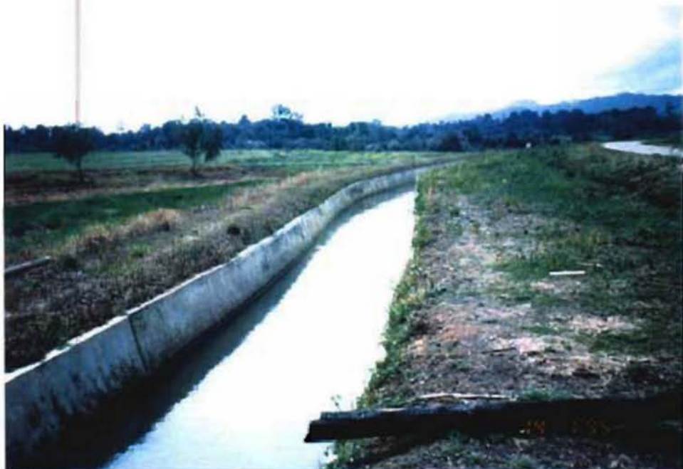
サモ幹線水路
