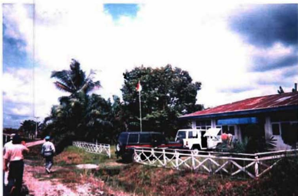
サモ地区現場事務所
