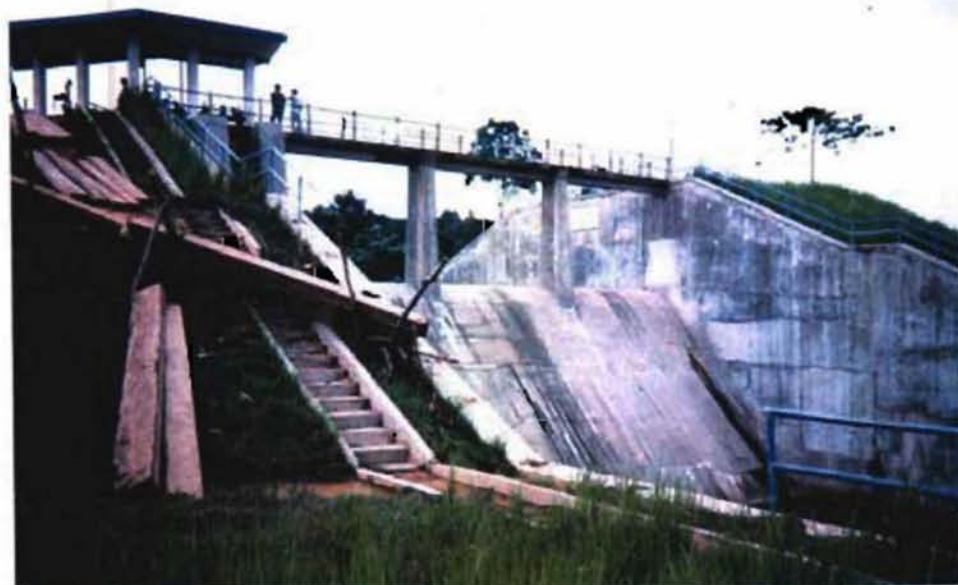
カイテイ頭首工 (下流側より)
