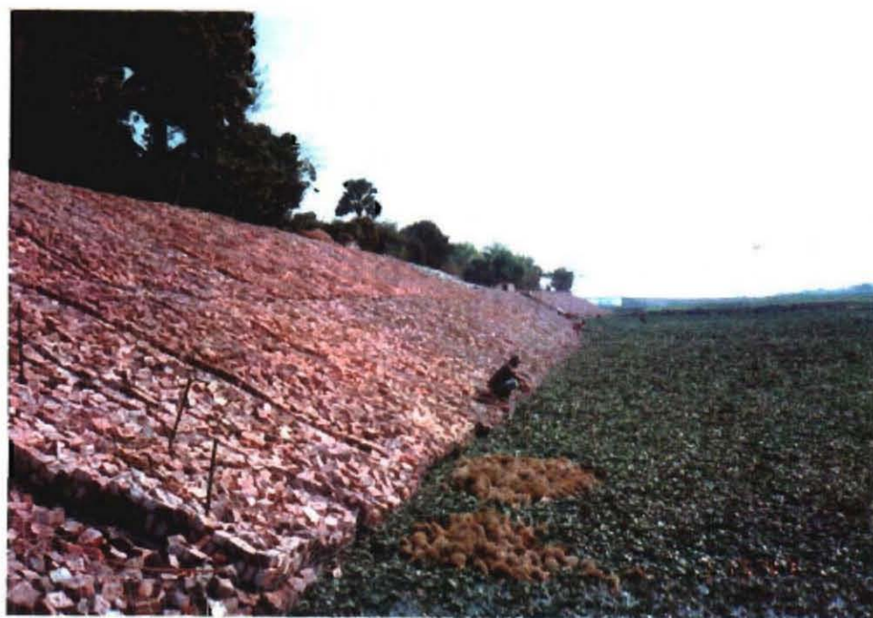
無償資金協力により実施された道路護岸工 (Homna のフィーダー道路B H-2)
