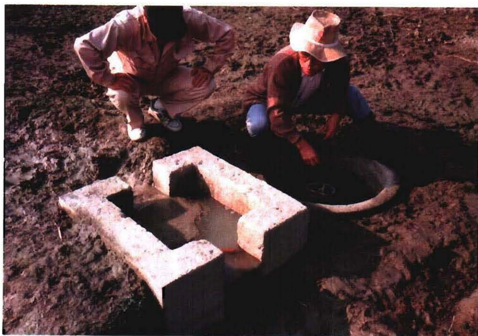
埋設パイプラインのバルブとアウトレット
