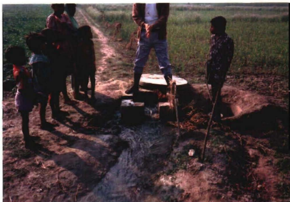
埋設パイプライン
