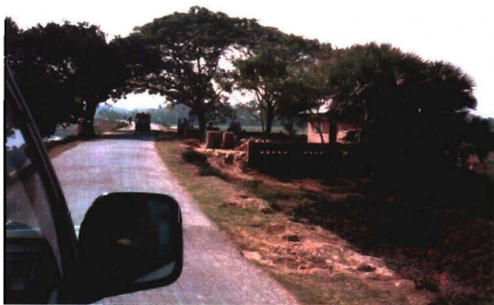
整備されたフィーダー道路B (Daudkandi のD-8) (車が入ってくるようになり、農産物の出荷が直ぐ出来るようになった)
