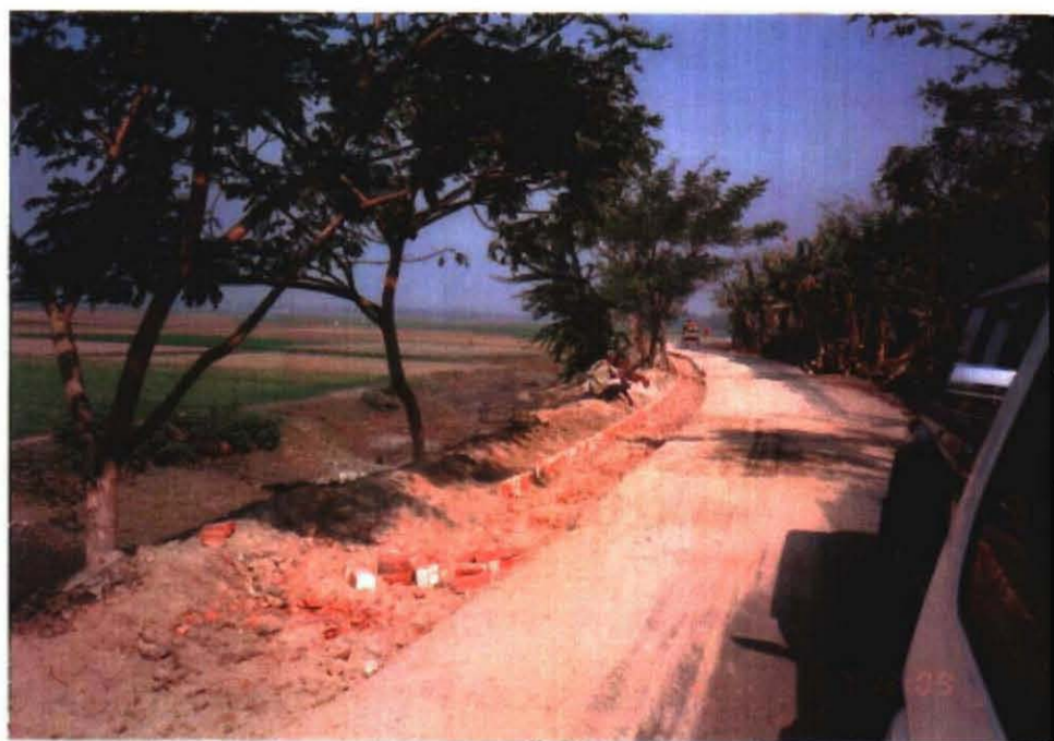
整備されたフィーダー道路B (Daudkandi のD-3) (Aに格上げになりR II Dが舗装路肩を補強工事実施している)
