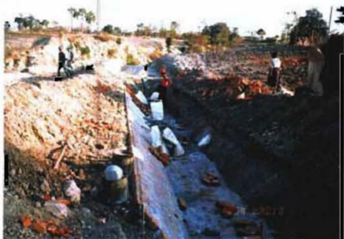
同上 用水路工事
