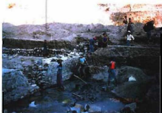
MASがFAOの協力で実施している ドライゾーンプロジェクトの取水堰工事
