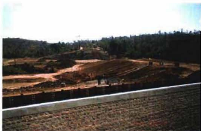
同上 工事風景
