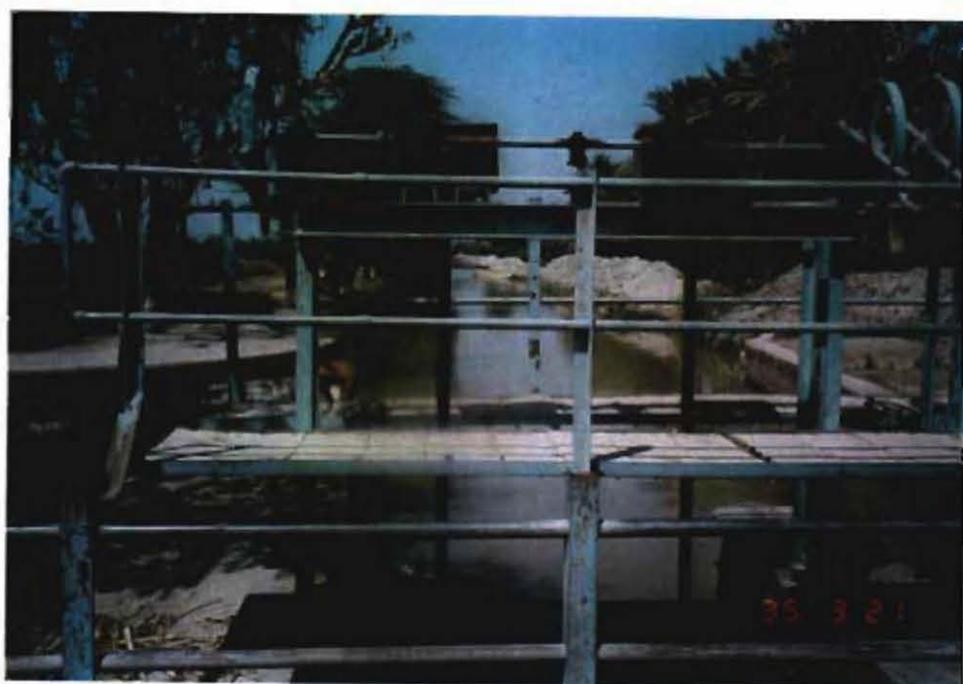
② WAH-BURA CANALの分水工 分水工付近のみコンクリート構造である
