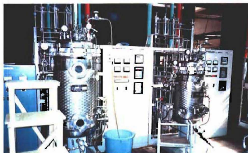
既存機材（大型発酵槽）
