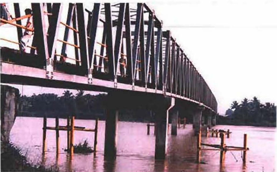
バルムン川下流に新しく架けられた橋（セイラキヤット村）
