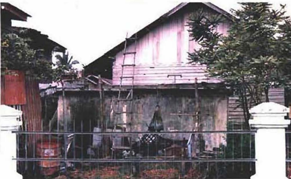
生活用水の備蓄のためのコンクリートタンク (ブルンバン町)
