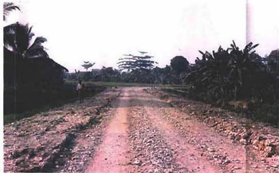
建設中の道路（セイラキヤット村） 1～2年中に最下流地域まで道路が整備される見通し。
