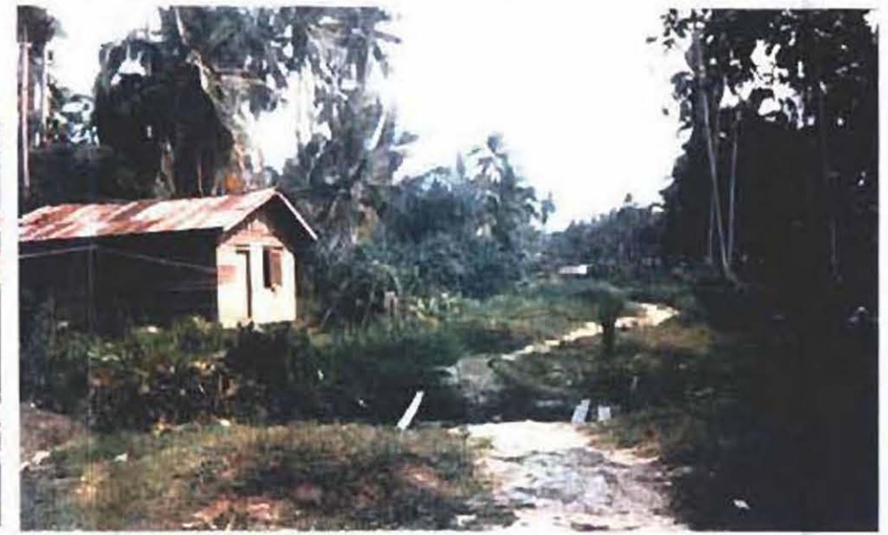
地区内道路の状況 (セイバル村) 道路は狭く悪状態で、クレークには橋がない。
