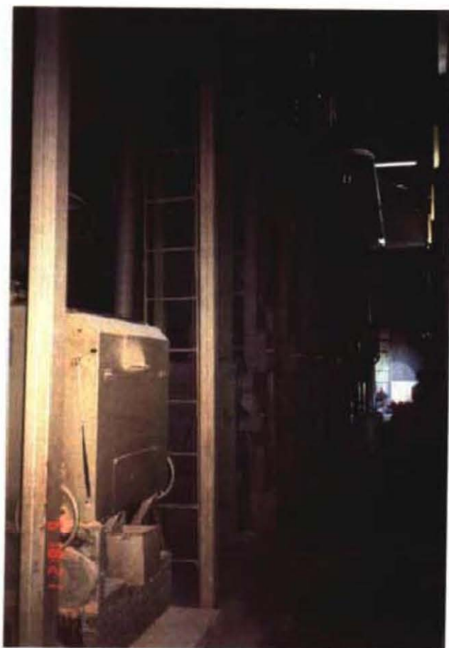
3. PUSKUD精米工場、4t/h (南スラウェシ州シドラップ県)
