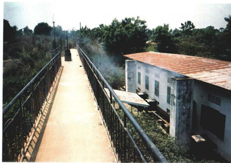
STATION DE MOTO-POMPE (ポンプ場)
