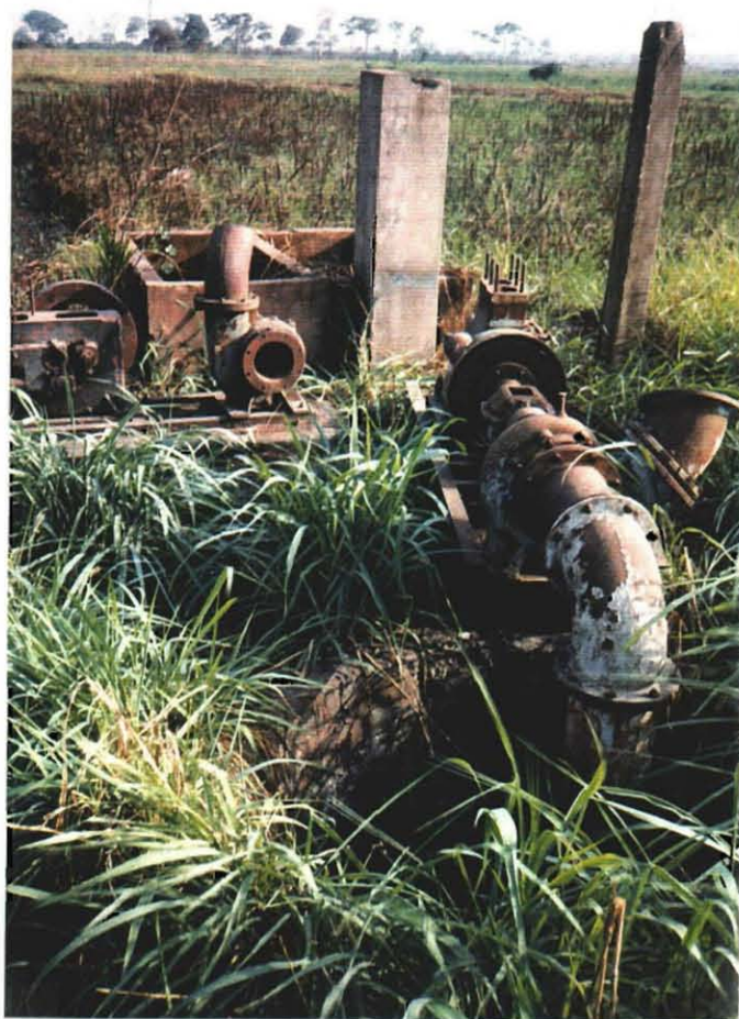
SITUATION DE MOTO-POMPE (ポンプ状況)
