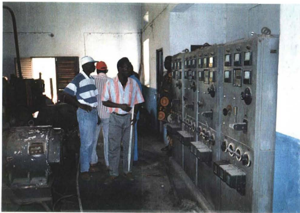
STATION DE MOTO-POMPE (ポンプ場)
