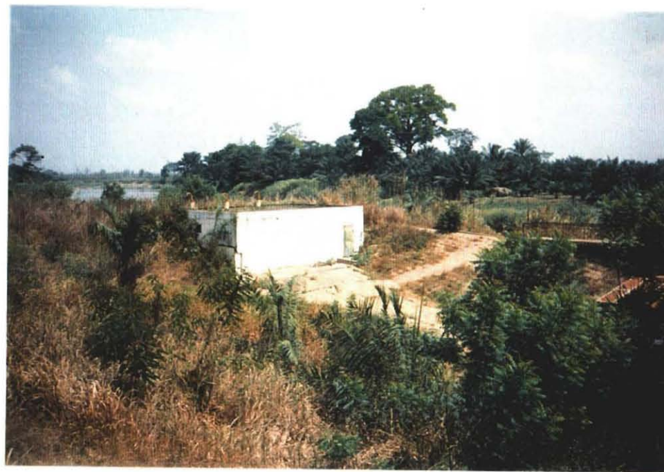
STATION DE MOTO-POMPE (ポンプ場)
