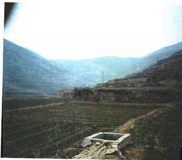
階段畑の灌漑施設（分土工） 貯水池に貯められた天水を利 用した畑灌漑
