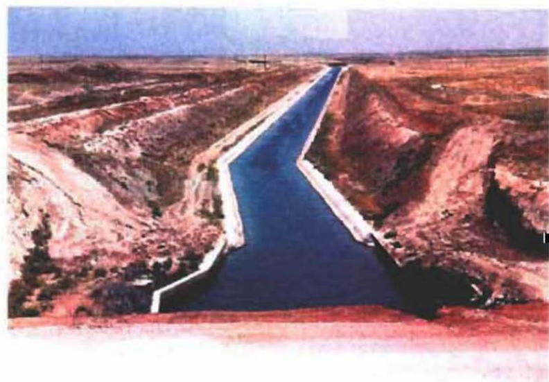
ハッサケダム直下の幹線導水路
